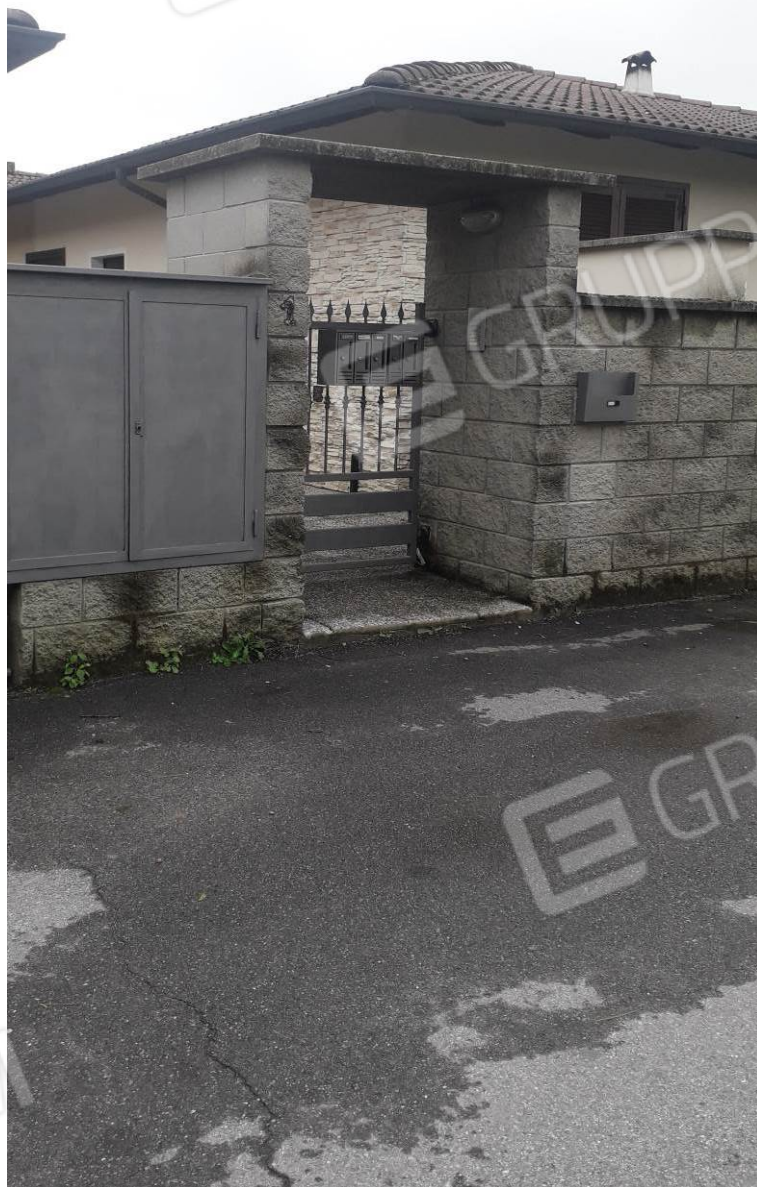
Ingresso pedonale comune
