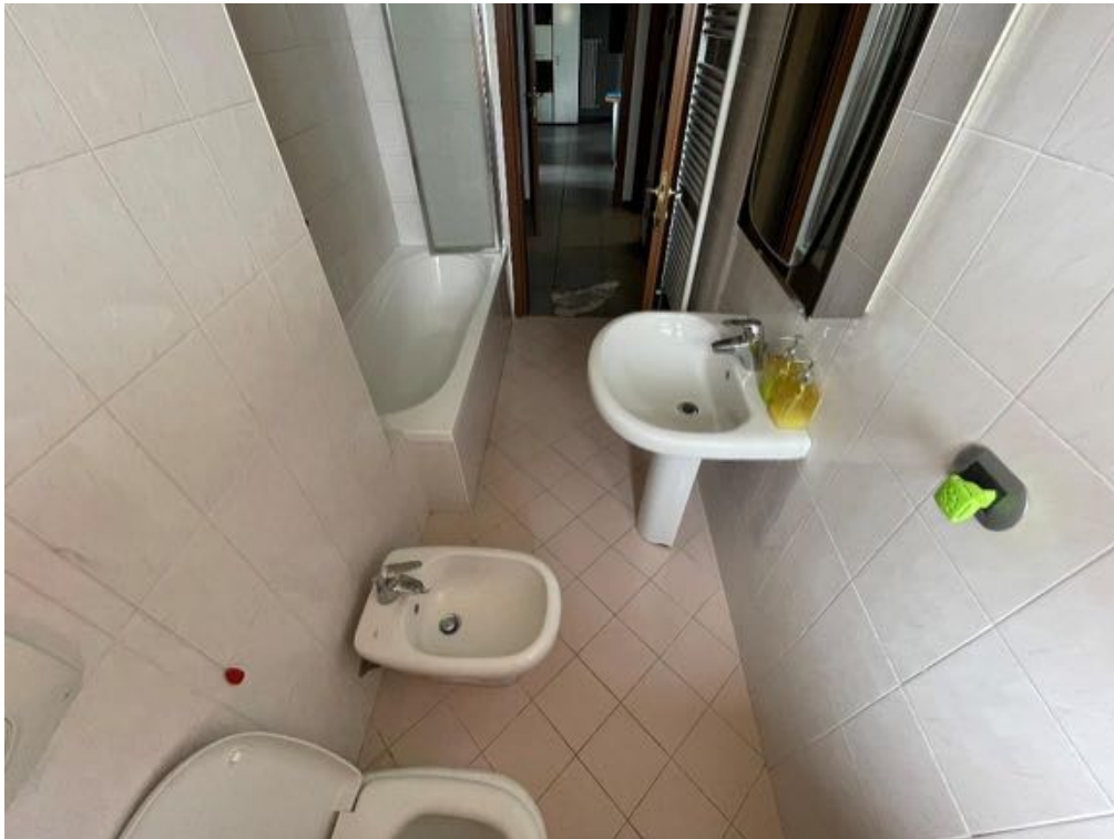
Piano Secondo - Appartamento (Sub. 34) - Bagno 1 (foto 2)
