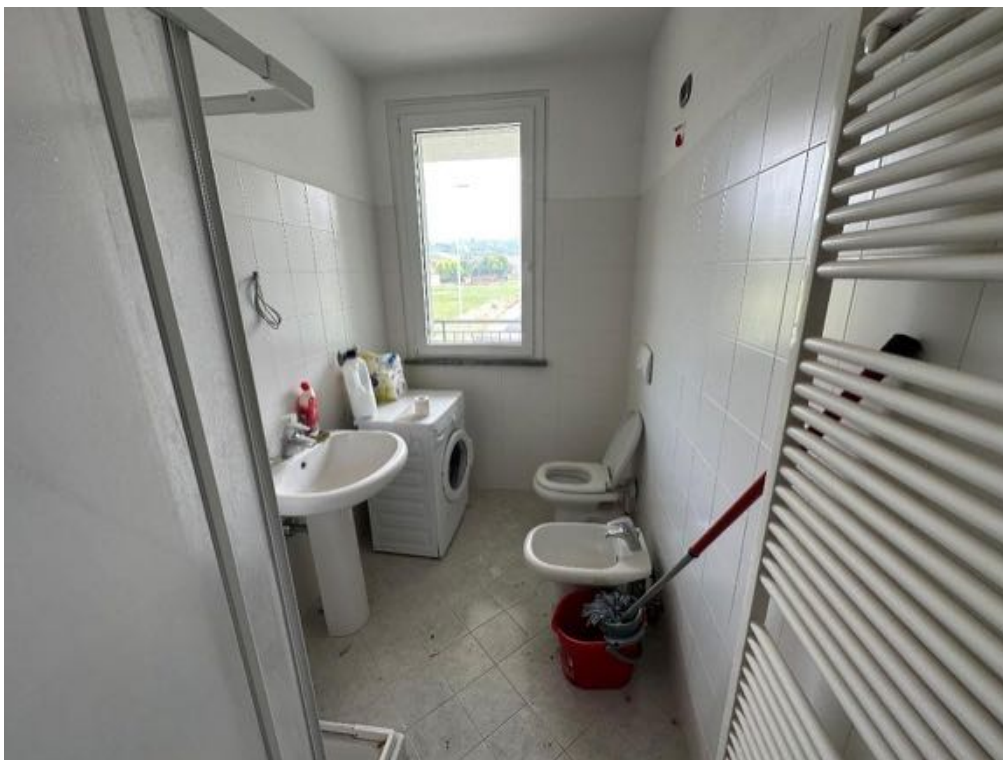
Piano Primo - Appartamento (Sub. 31) - Bagno (foto 1)
