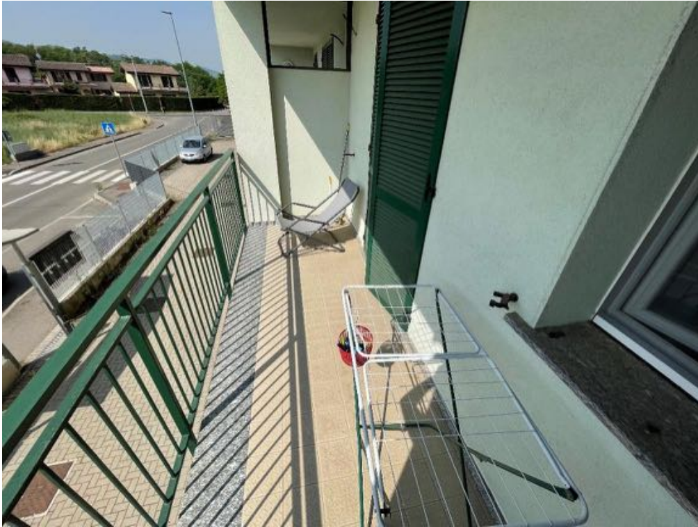
Piano Primo - Appartamento (Sub. 32) - Loggia
