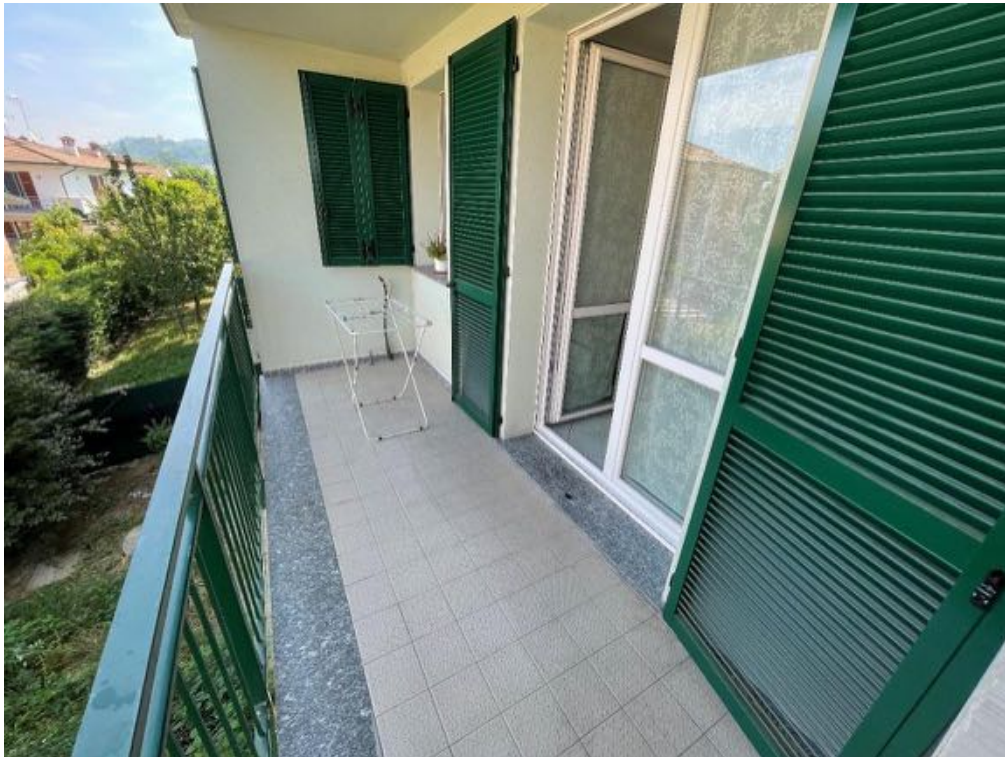
Piano Primo - Appartamento (Sub. 33) - Loggia
