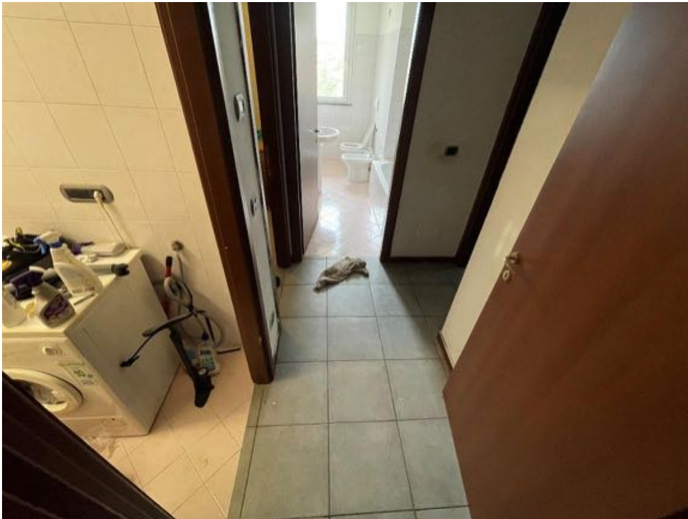
Piano Secondo - Appartamento (Sub. 34) - Disimpegno
