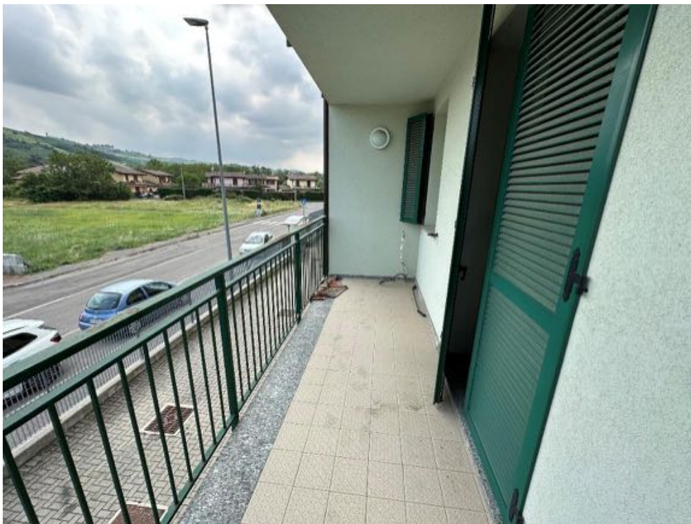
Piano Primo - Appartamento (Sub. 31) - Loggia (foto 2)
