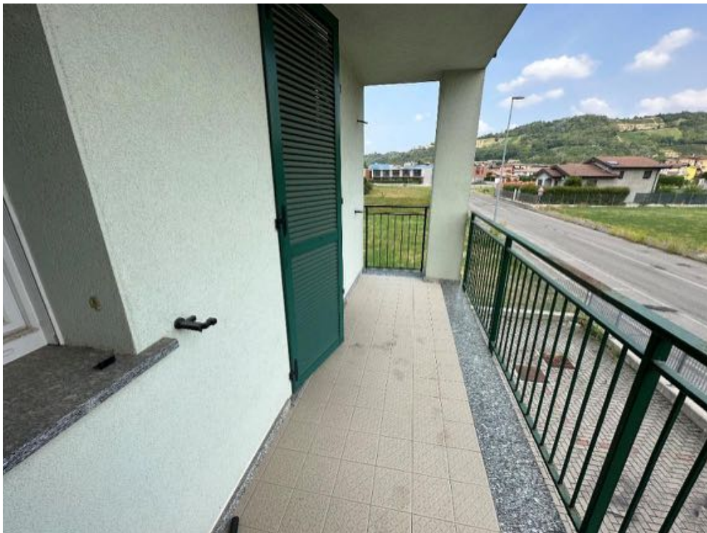
Piano Primo - Appartamento (Sub. 31) - Loggia (foto 1)
