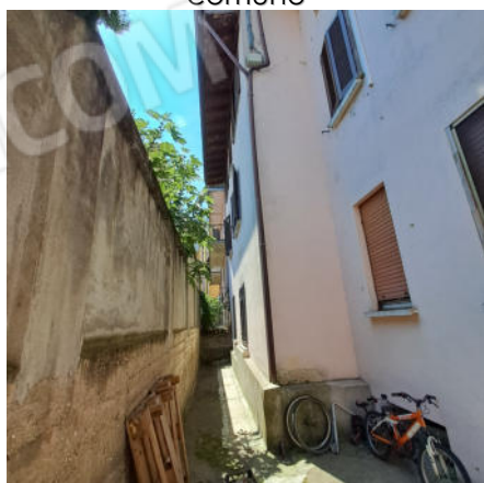
Foto 5 - Lato est del condominio
