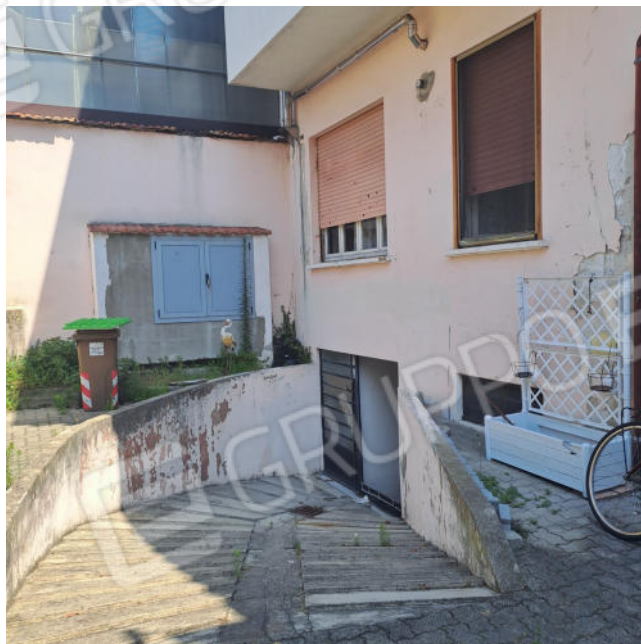
Foto 4 - Accesso alle cantine del piano interrato
