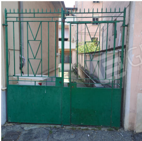
Foto 1-Cancello d'ingresso sulla Via Donizetti
