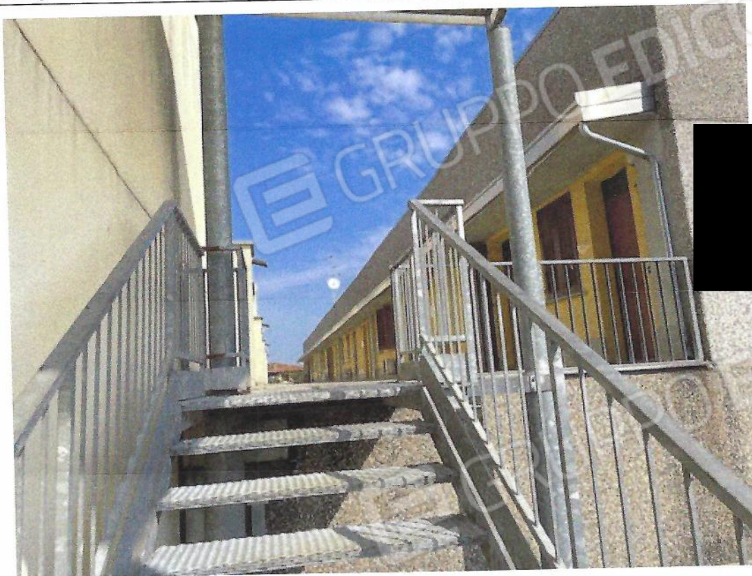
Scala esterna che conduce al Ballatoio Comune per accesso Unità Immobiliare
