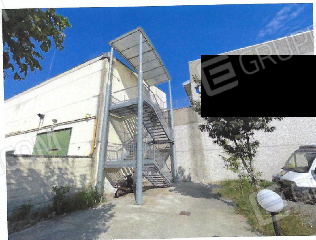
Scala esterna che conduce al Ballatoio Comune per accesso Unità Immobiliare
