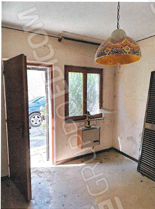
foto 9 – vista interna dell’immobile P.T., zona giorno 3.
