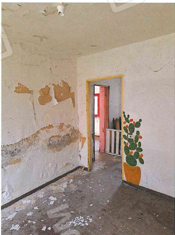
foto 7 – vista interna dell’immobile P.T., zona giorno 1.
