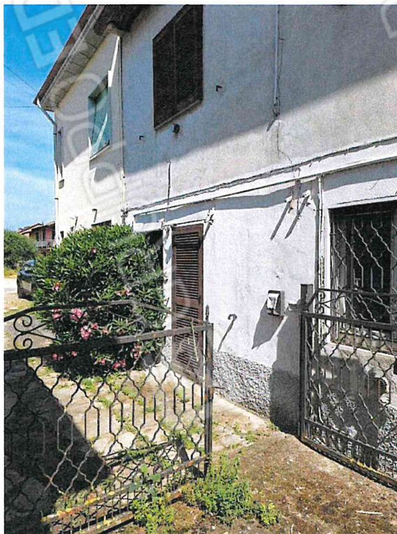
foto 2 – vista esterna dell'immobile, prospetto Sud.
