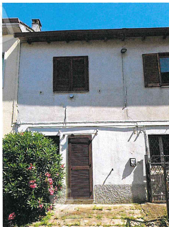
foto 3 – vista esterna dell'immobile, prospetto Sud.
