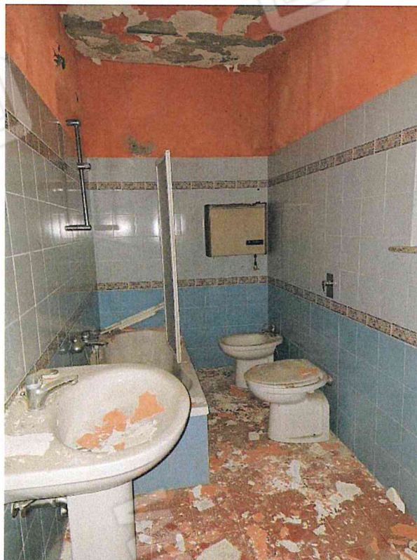
foto 11 – vista interna dell’immobile P.T., servizio igienico.
