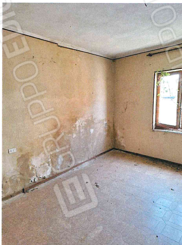
foto 18 – vista interna dell’immobile P.1°, camera da letto 3.
