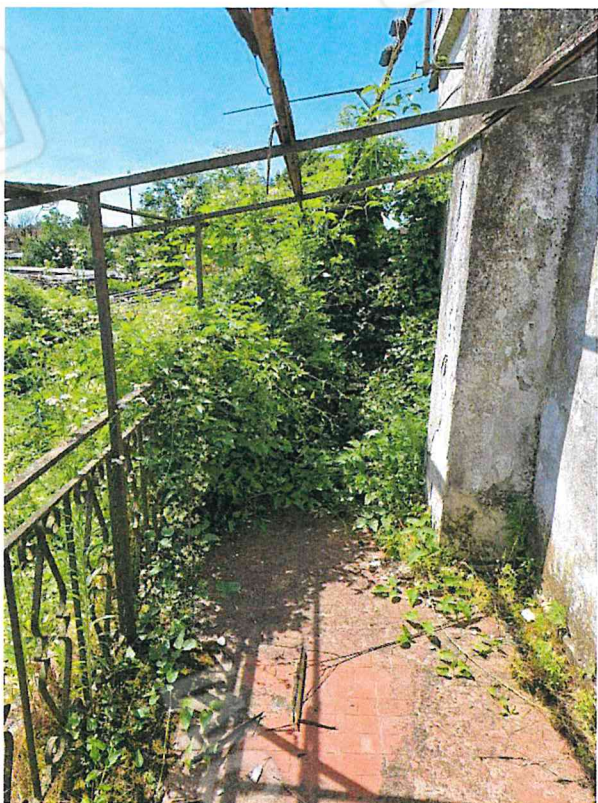
foto 19 – vista esterna dell’immobile P.1°, balcone.
