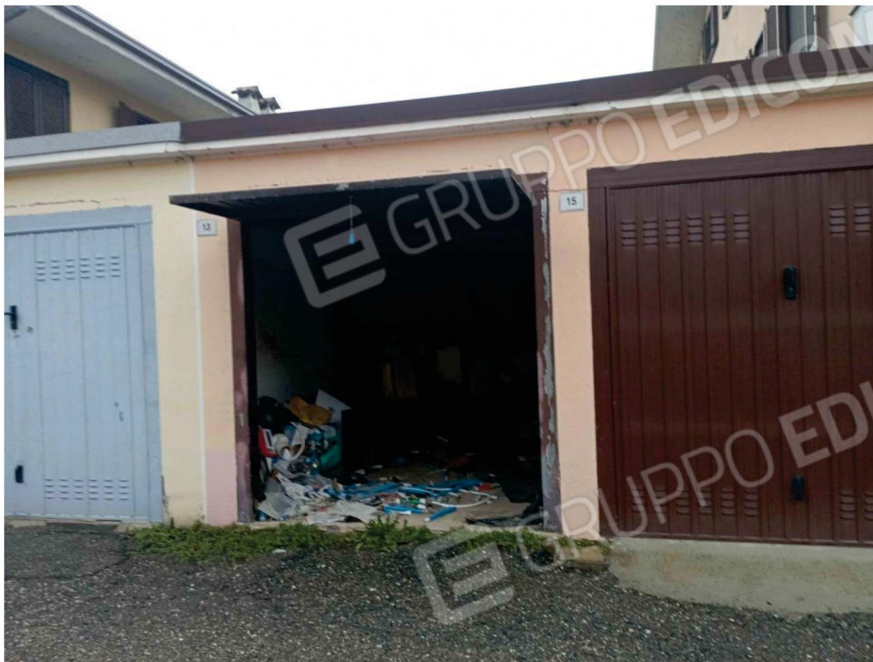
AUTORIMESSA - Accesso da via Deledda
