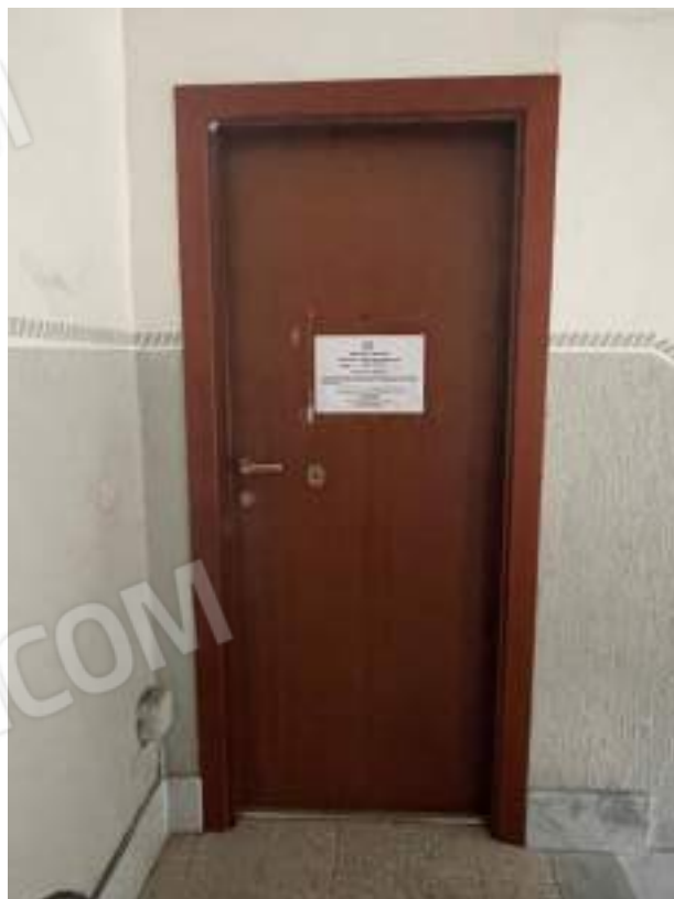
Ingresso Unità Immobiliare al Piano Terzo – sub. 17
