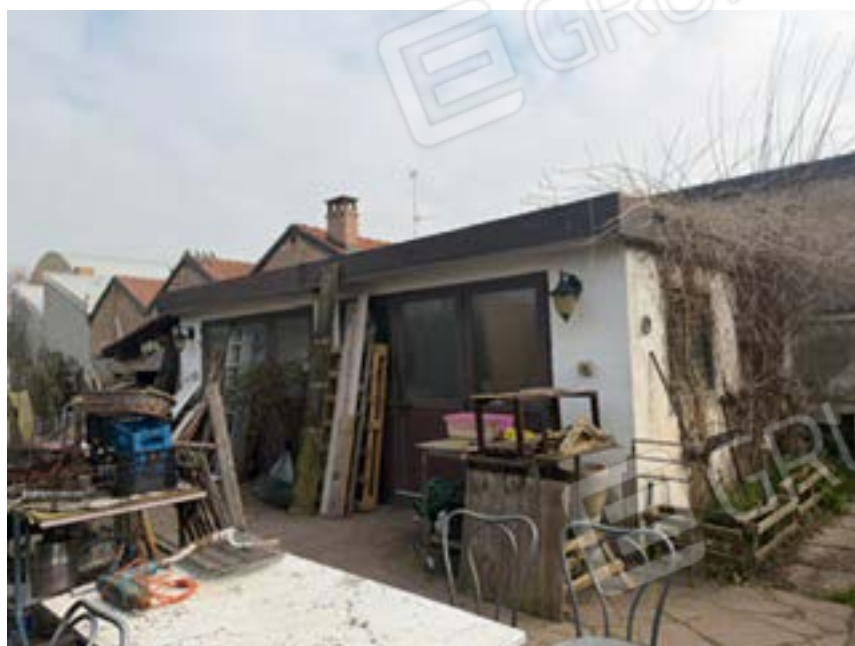
FOTO ESTERNE – AUTORIMESSA
