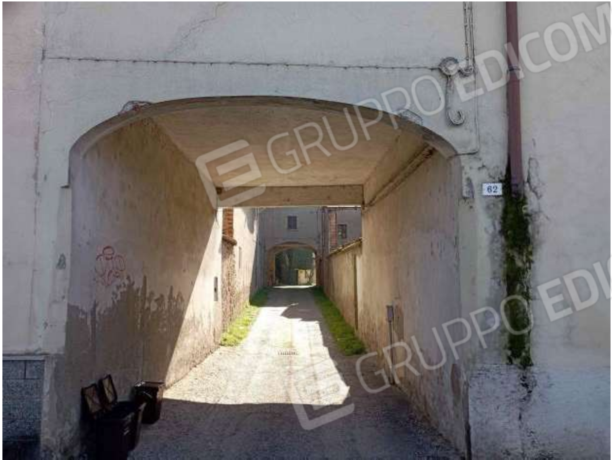
Ingresso a prolungamento interno via Mazzini 62
