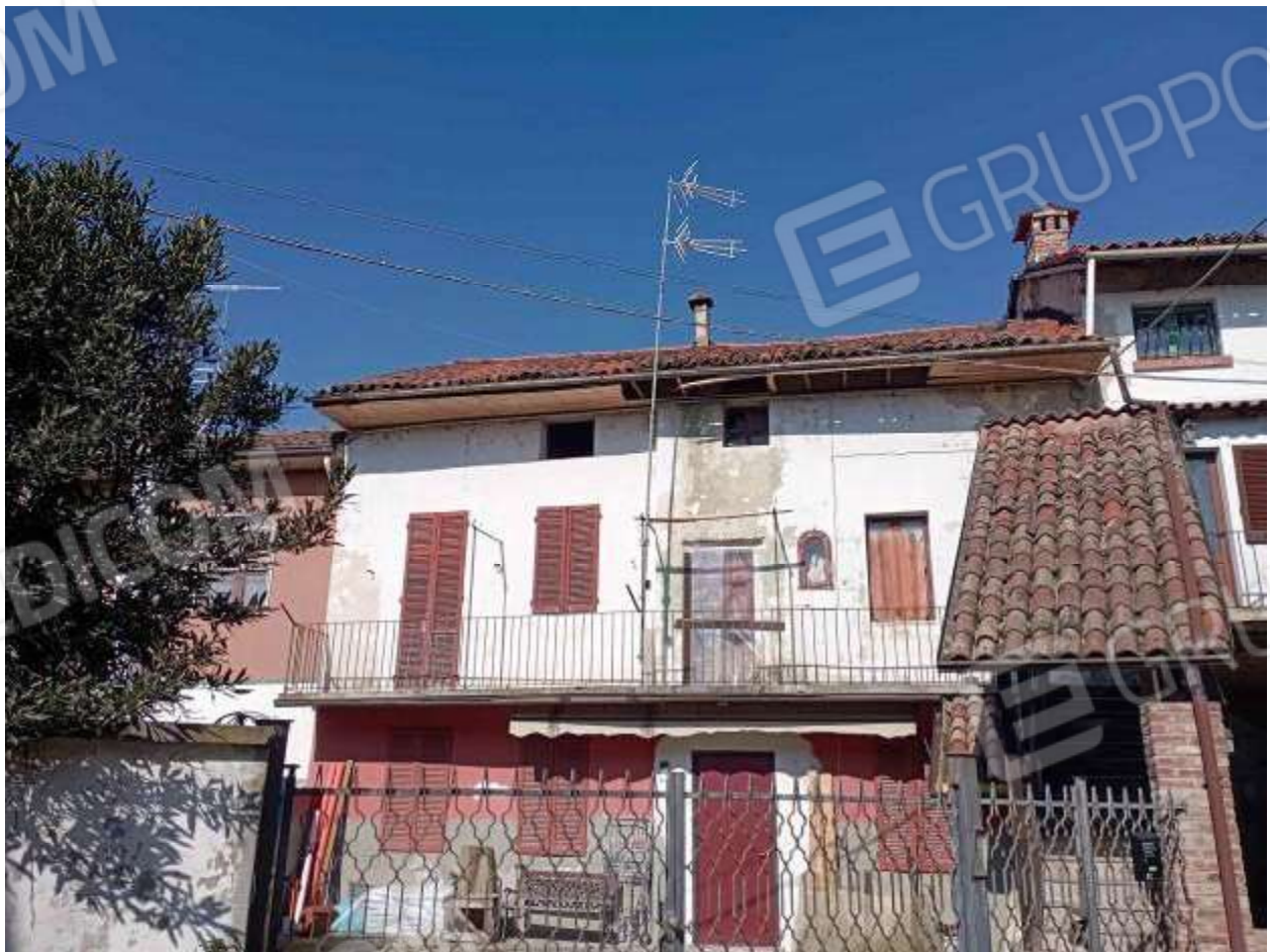
Prospetto principale e accesso al cortile comune lato Sud
