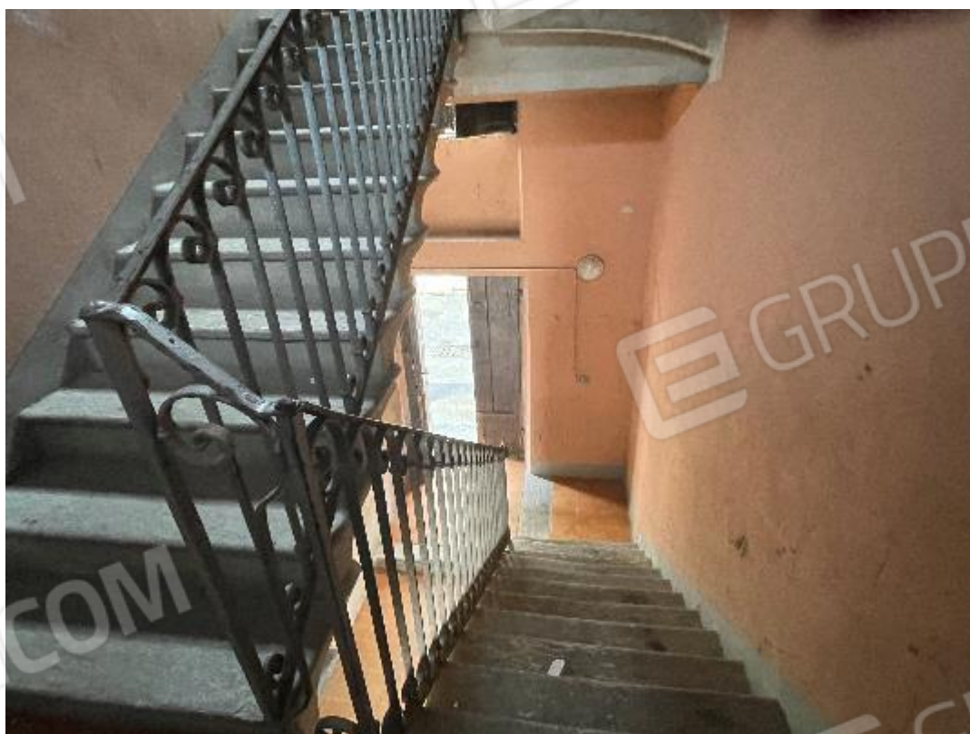
Scala di accesso al piano primo
