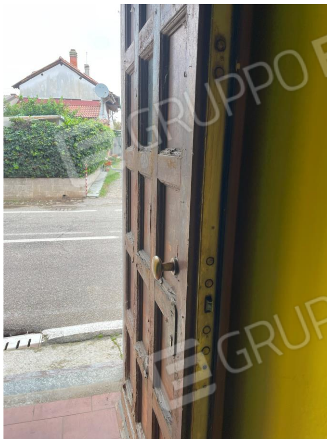
Foto 5. - Portoncino di ingresso
