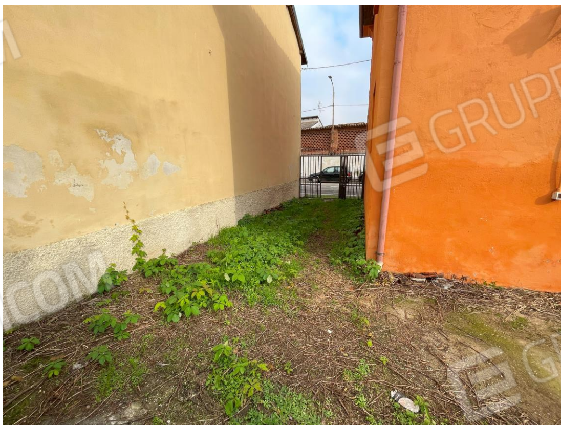
Foto 56. - Vista dell'accesso carrabile al cortile pertinenziale
