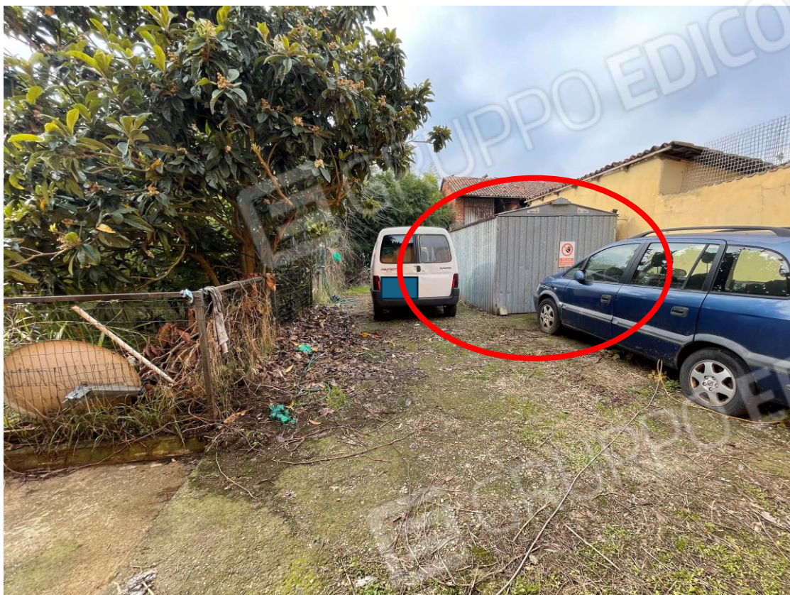
Foto 53. - Baracca in metallo sul cortile che dovrà essere rimossa
