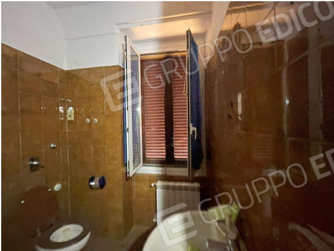
Foto 37. - Bagno 3 al primo piano
