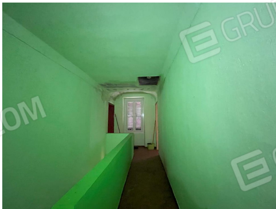
Foto 20. - Sbarco scala al piano primo
