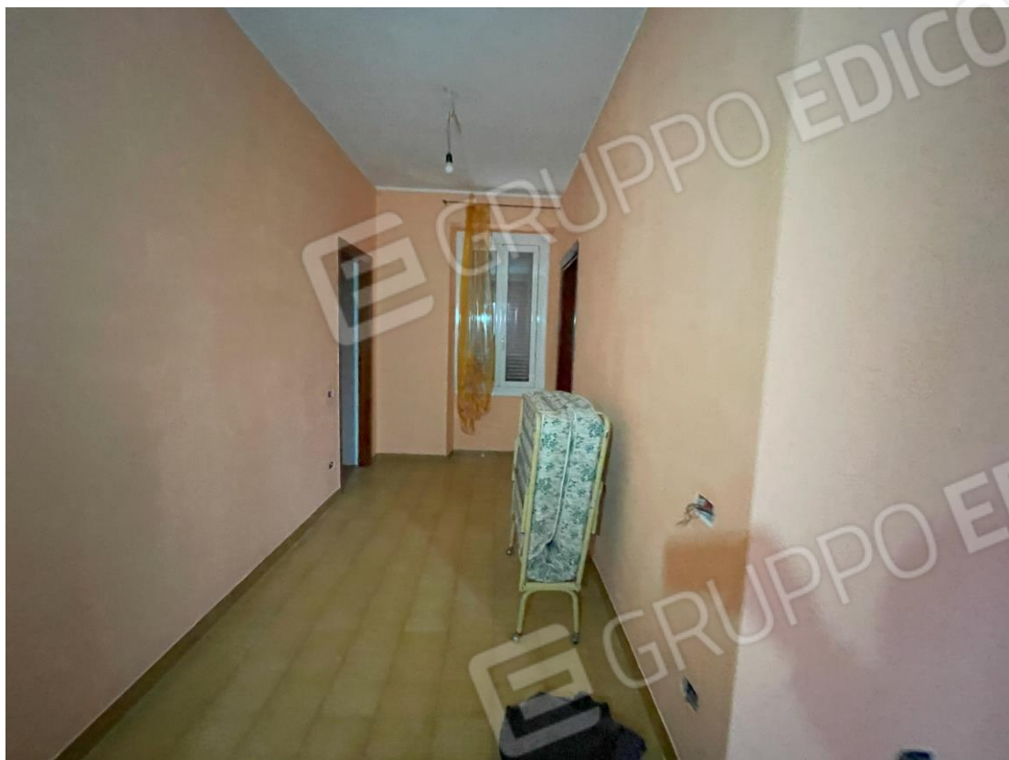
Foto 27. - Camera al piano primo: ingresso bagno 2 e ripostiglio
