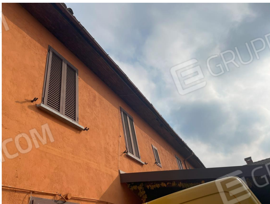
Foto 48. - Vista prospetto ovest con tettoia non autorizzata
