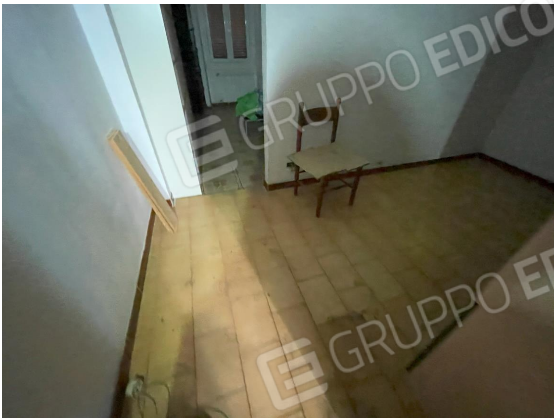
Foto 33. - Disimpegno cieco al primo piano
