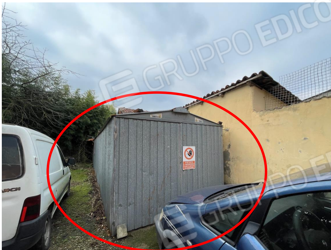
Foto 55. - Baracca in metallo sul cortile che dovrà essere rimossa
