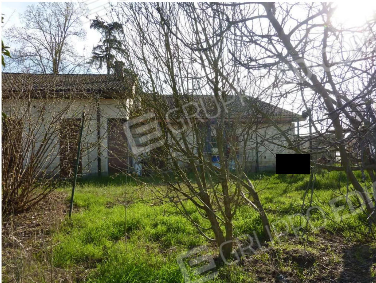
6. Fronte Nord degli immobili
