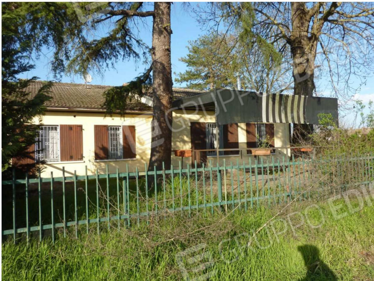
2. Parte degli immobili dal fronte strada
