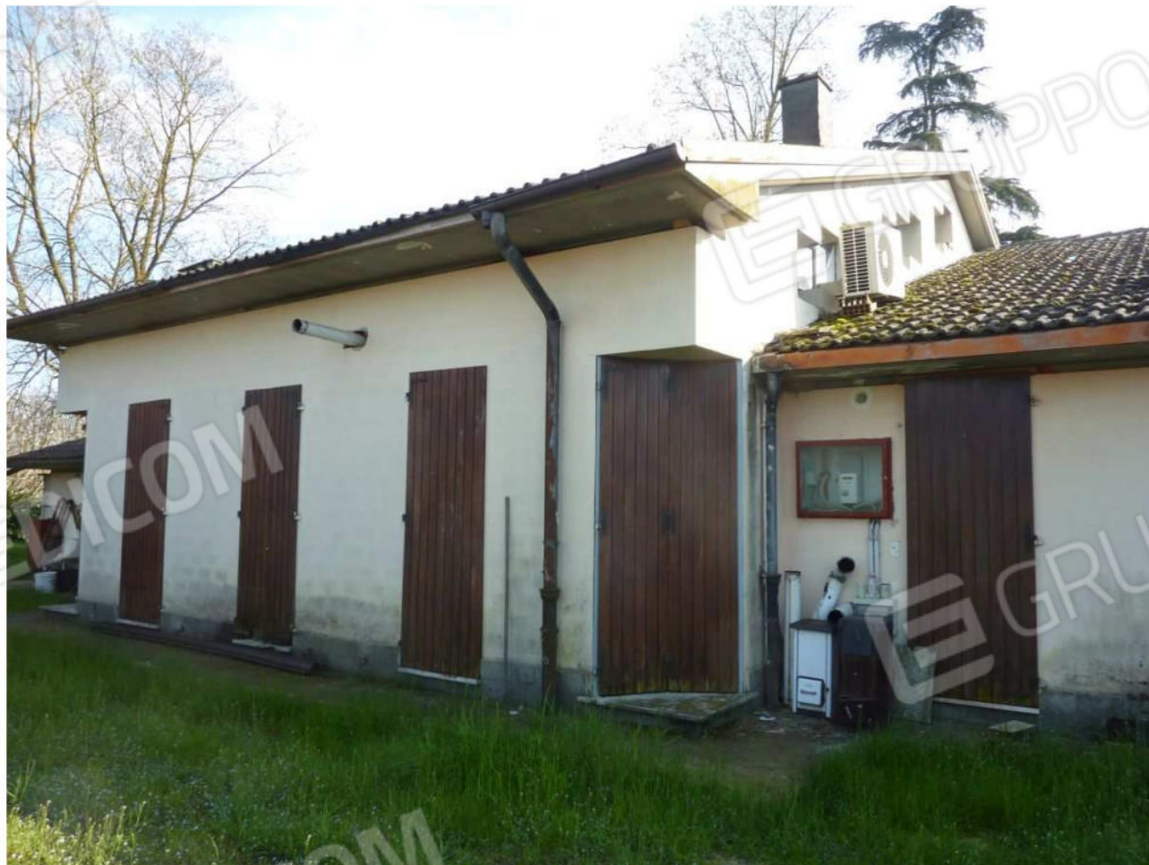
5. Fronte Nord degli immobili
