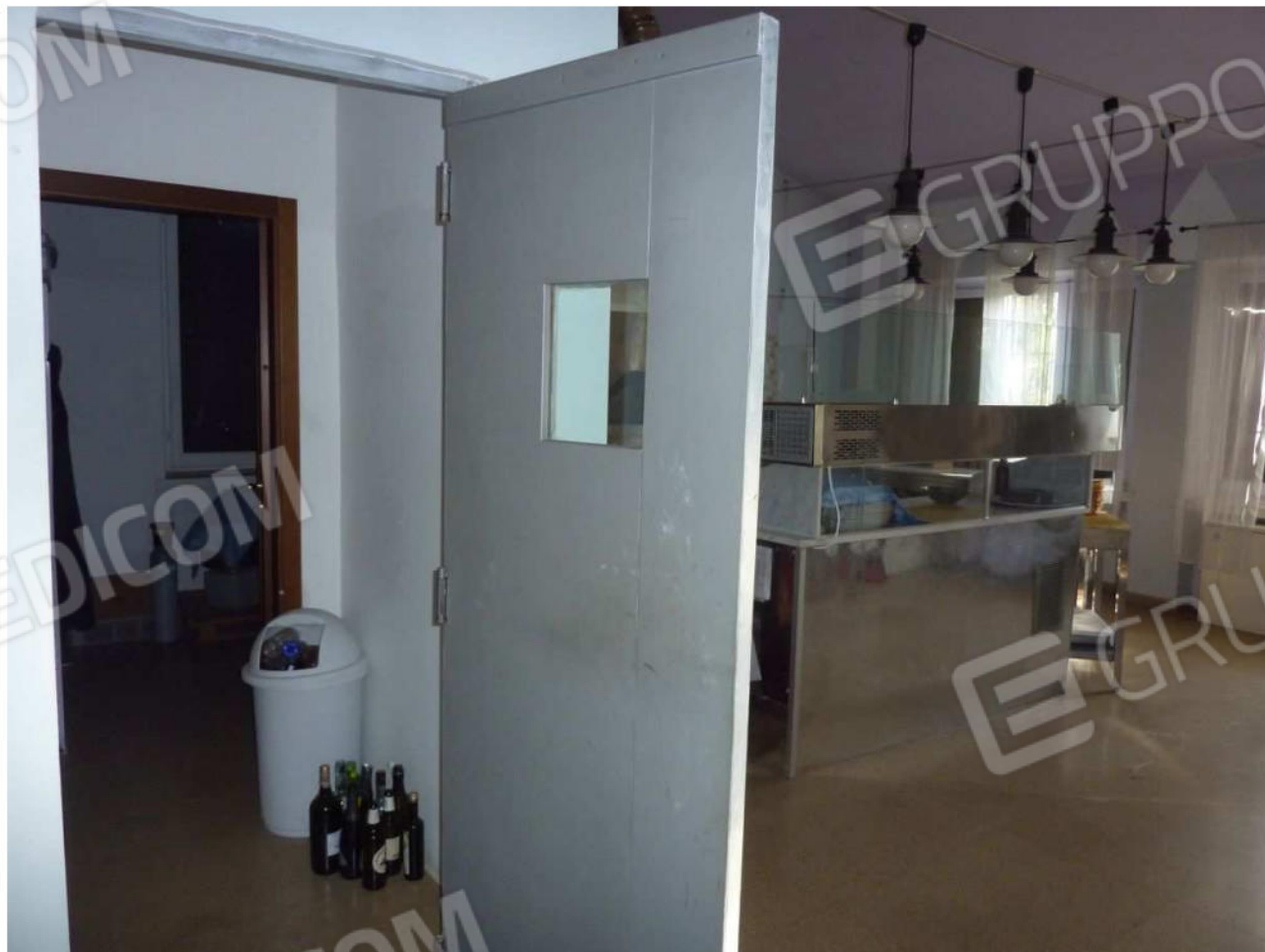
27. Accesso al locale deposito dalla saletta ristorante
