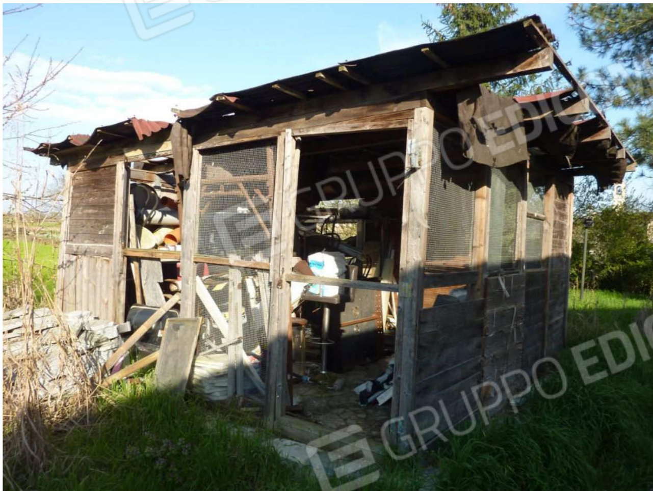
12. Particolare dello stato della "voliera"
