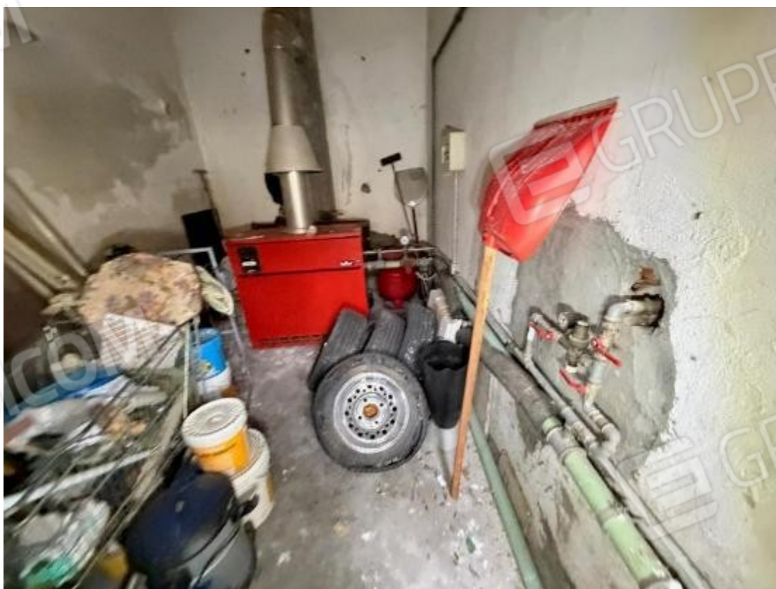
Centrale Termica in disuso
