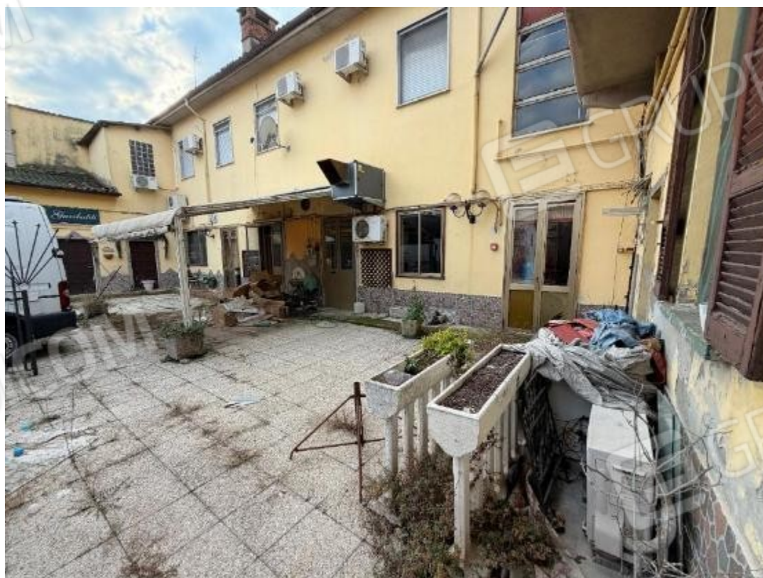
Vista Esterna cortiletto interno
