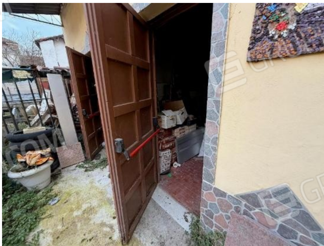
Ingresso locale accumulo ACS
