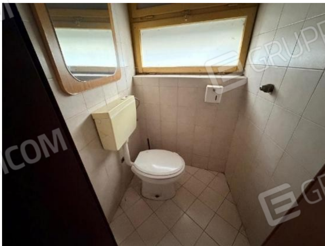
Particolare sanitari Secondo locale bagno
