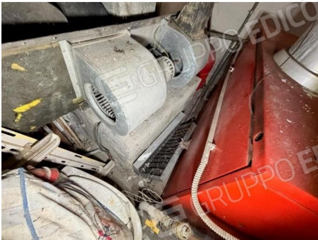
Centrale Termica in disuso
