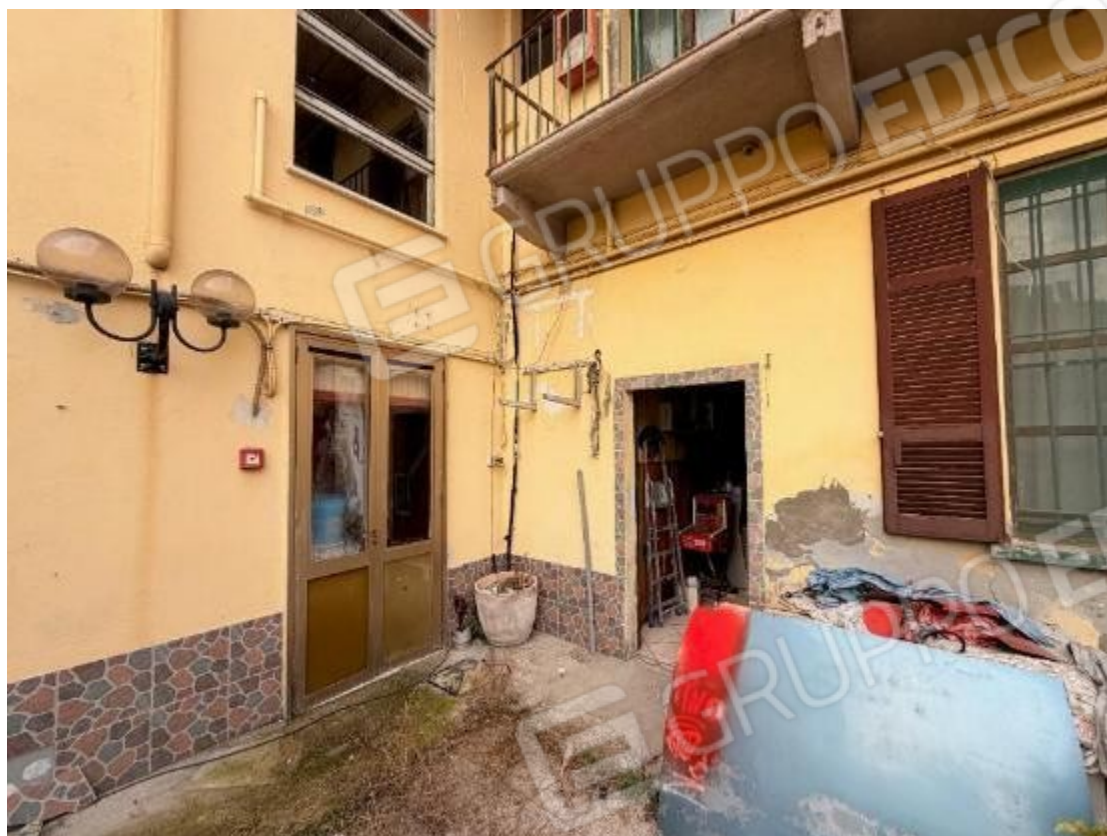
Vista Esterna cortiletto interno
