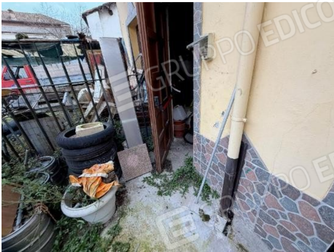
Accesso a Centrale Termica
