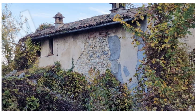
2. Veduta esterna del fabbricato part.403
