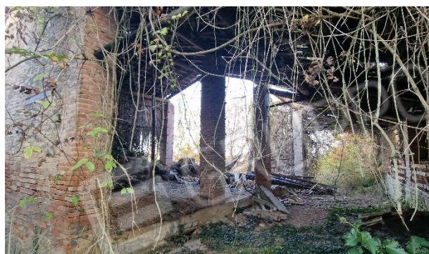
3. Veduta esterna part.404
