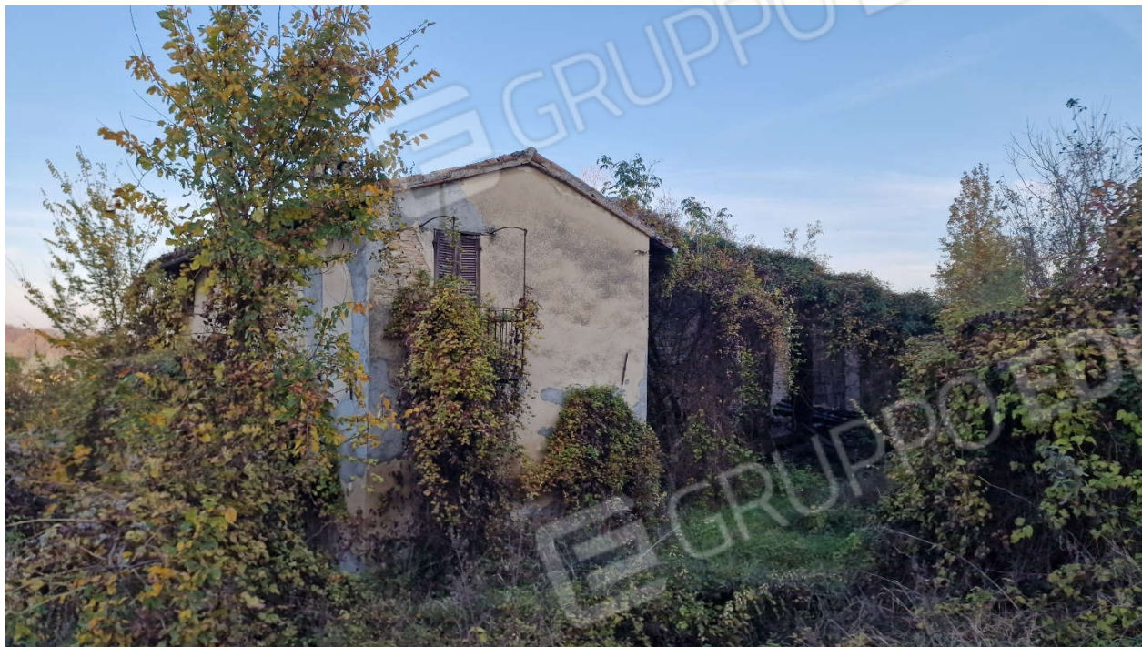
1. Veduta esterna del fabbricato part.403
