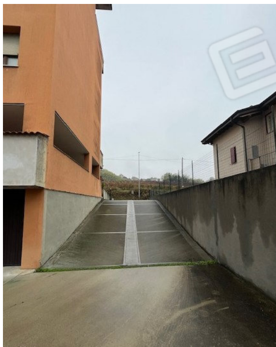
Vista rampa carraia
