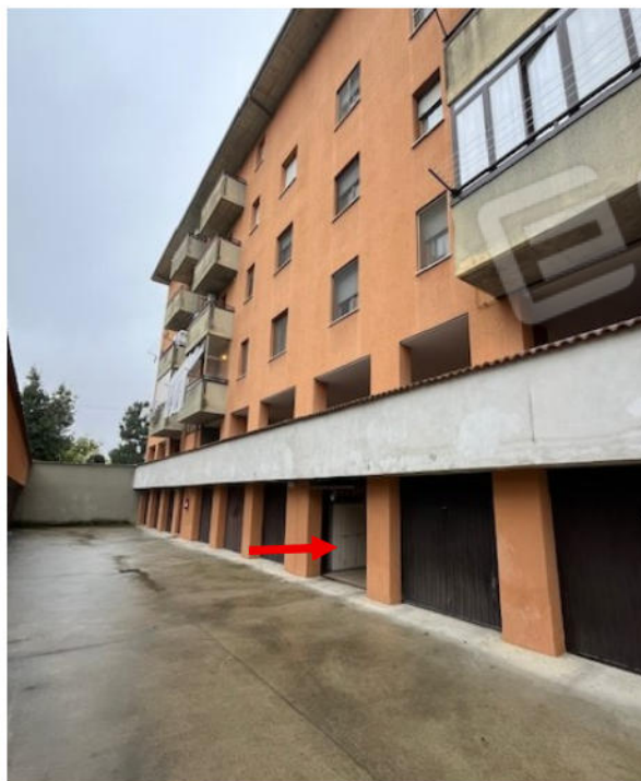
Vista corte comune con ingresso al box
