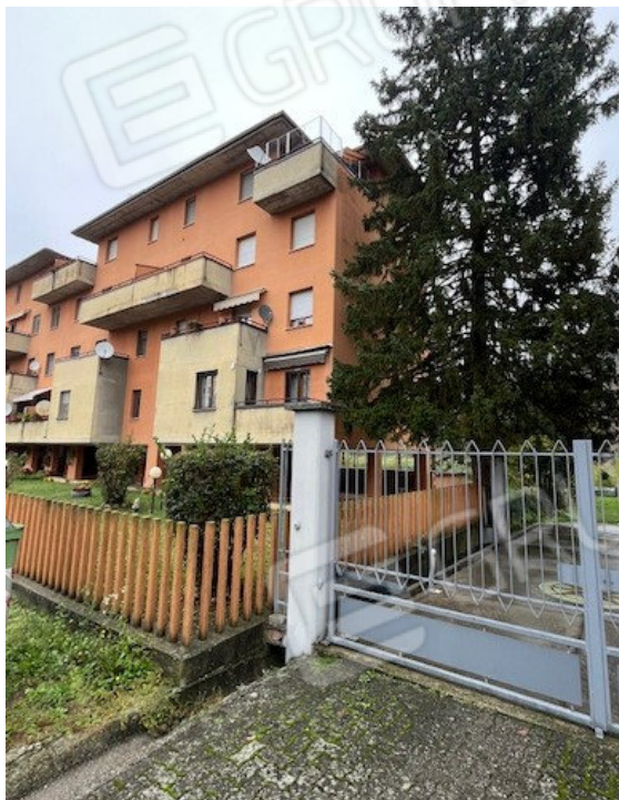
Vista prospetto sud
