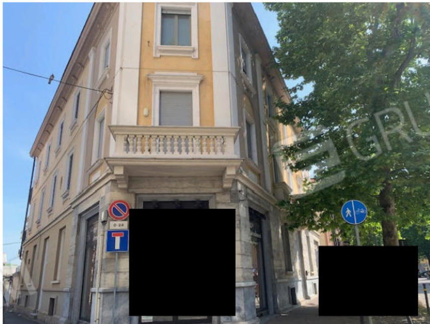
FOTO ESTERNE – EDIFICIO DI RIFERIMENTO
