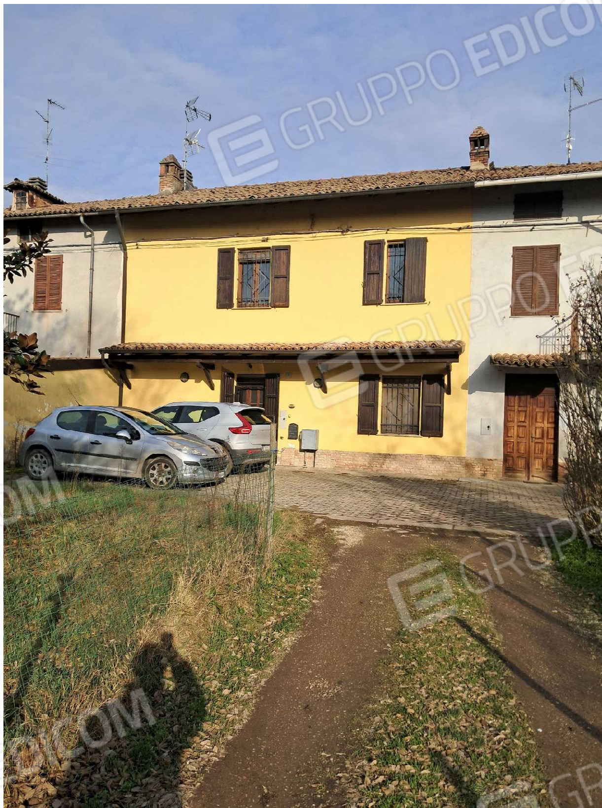
FACCIATA LATO SUD
