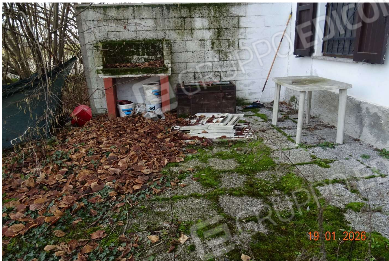
AREA LATO NORD
