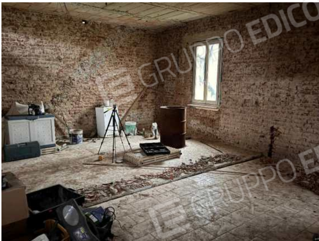
Piano Terra – locale soggiorno: tramezza verso cucina demolita
