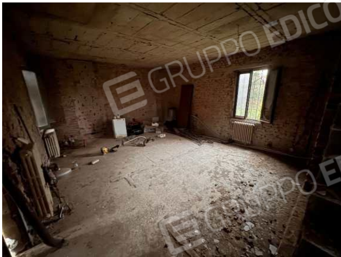
Soggiorno e Cucina (demolite tramezze) – altra vista
