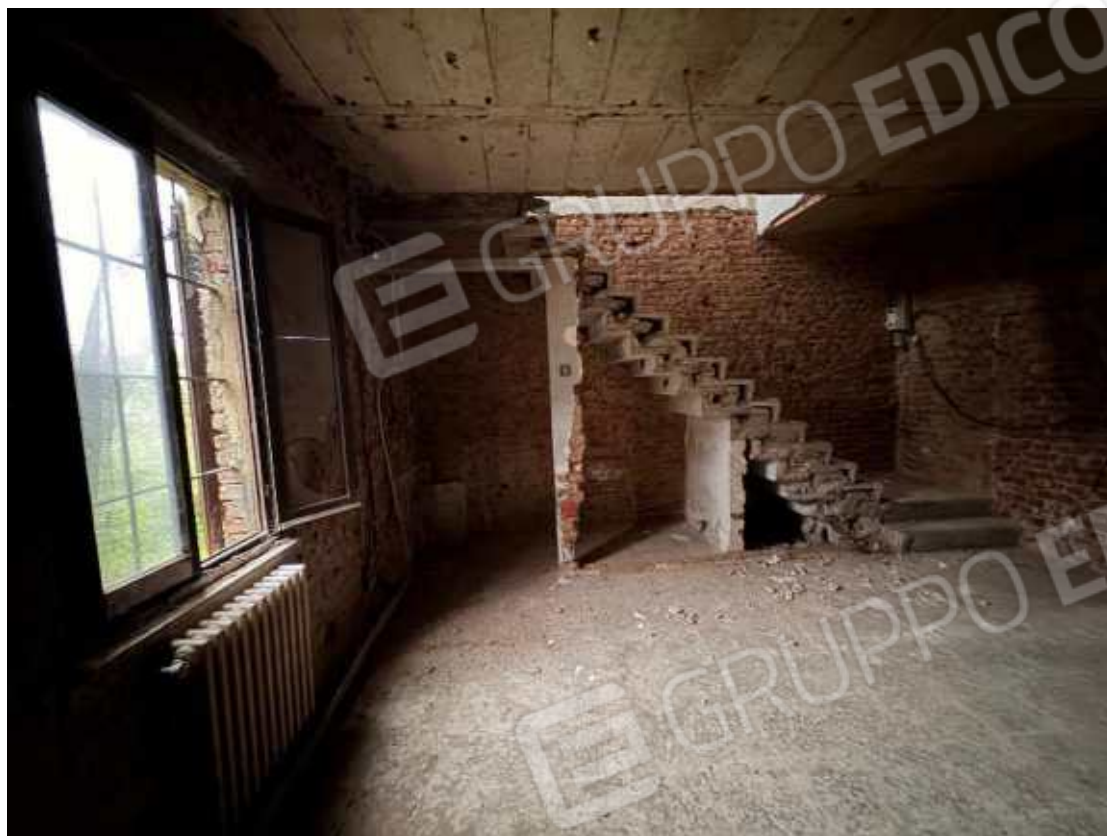
Soggiorno e Cucina (demolite tramezze) – altra vista
