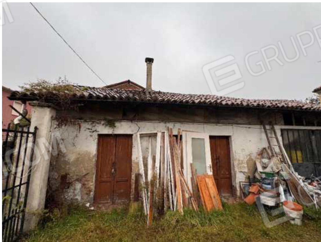
Vista Esterno Autorimessa - Deposito
