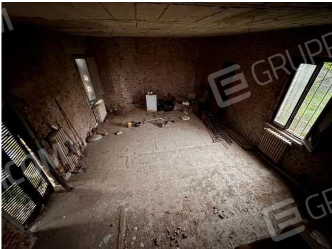
Soggiorno e Cucina (demolite tramezze)
