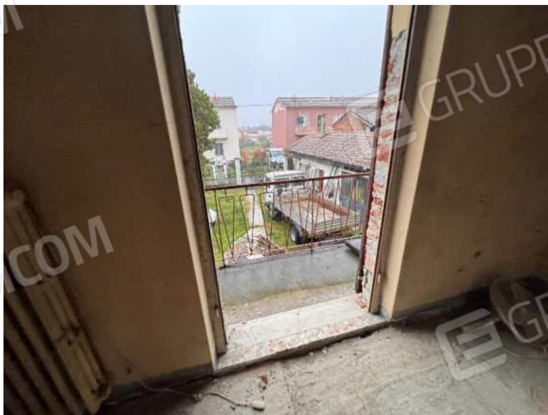
Camera da Letto – accesso al poggiolo
