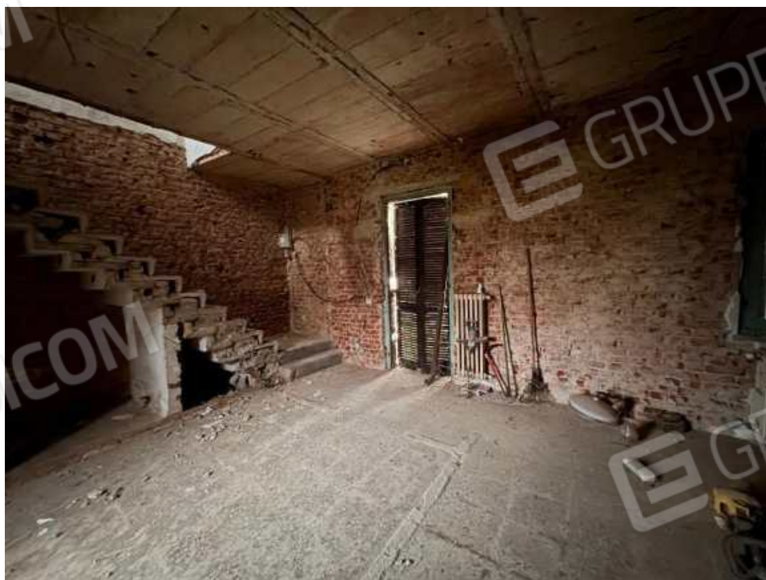
Soggiorno e Cucina (demolite tramezze) – altra vista
