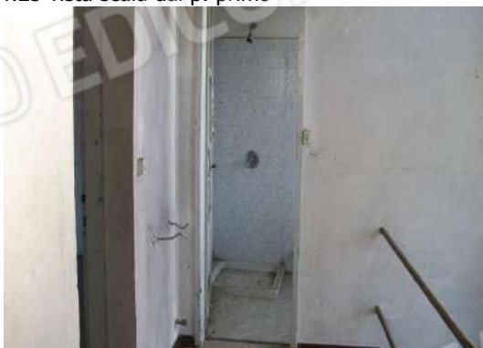
f.29 vista ingresso bagno
