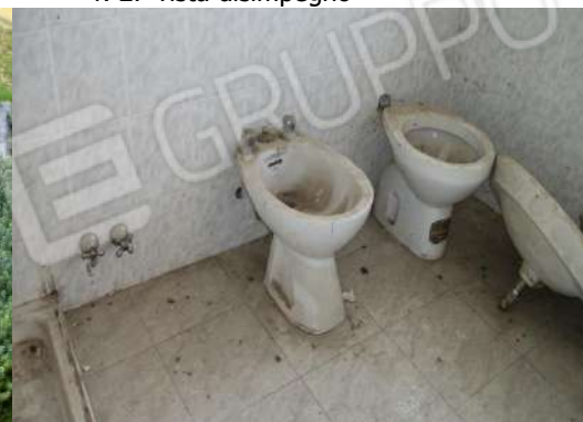
f.31 vista bagno
