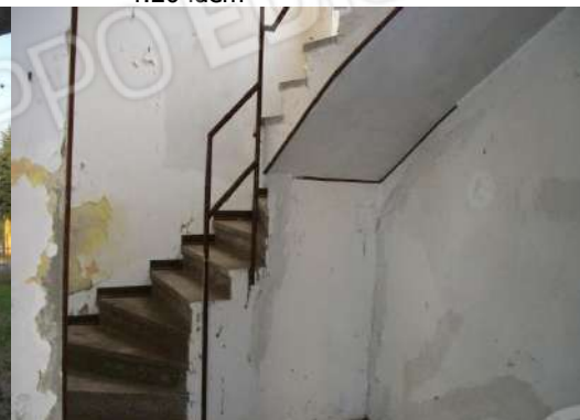
f.24 vista vano scala edificio C
