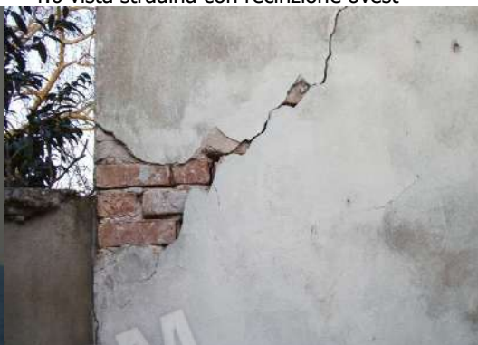
f.10 vista dissesto angolo muratura edificio C su stradina f. 11 vista terreno mapp. 234
