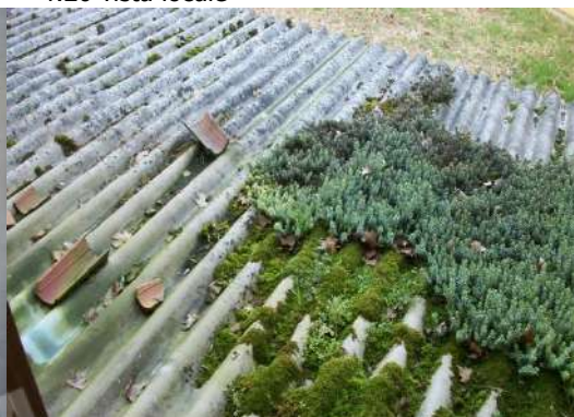
f.30 vista manto eternit tettoia
