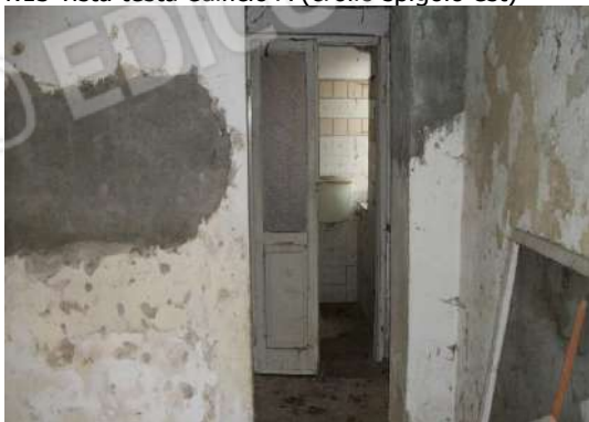
f.17 vista interno edificio A
