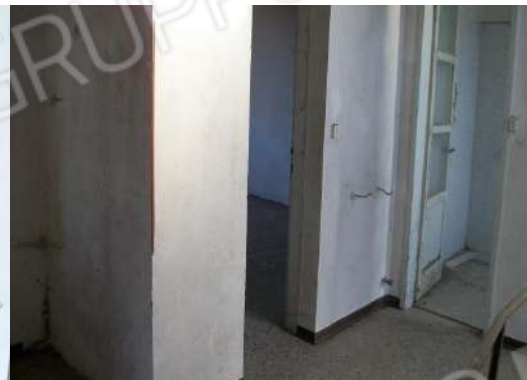
f. 27 vista disimpegno
