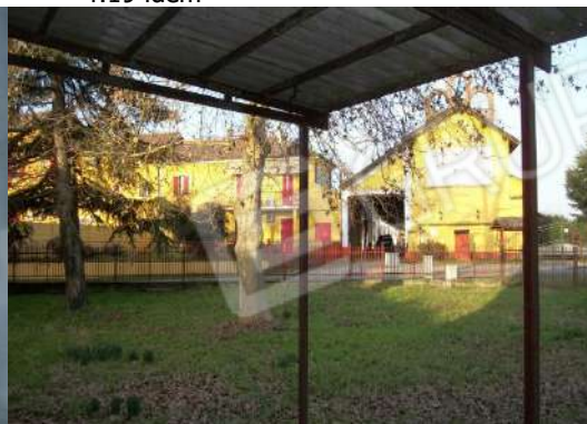
f.23 vista sotto tettoia edificio C
