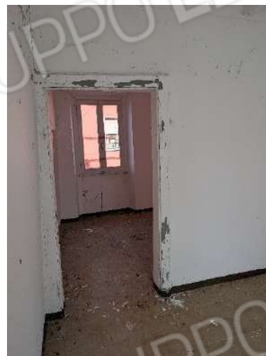
dal disimpegno alla camera
