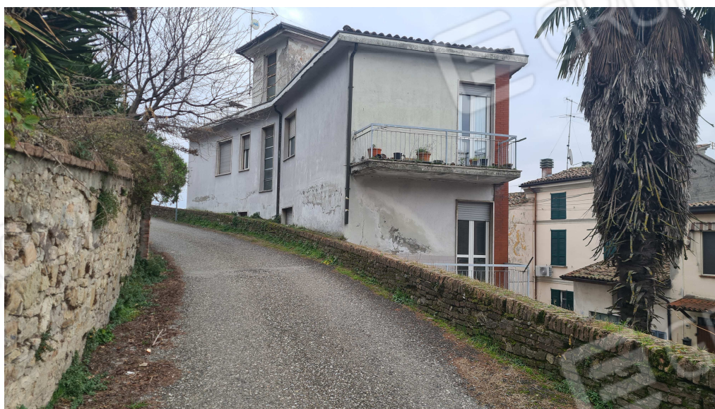
Prospetto retrostante verso Via Castello
