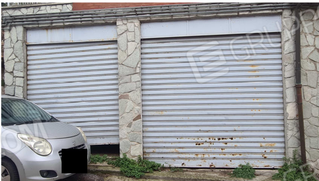
Autorimesse sub 4 e sub 5
