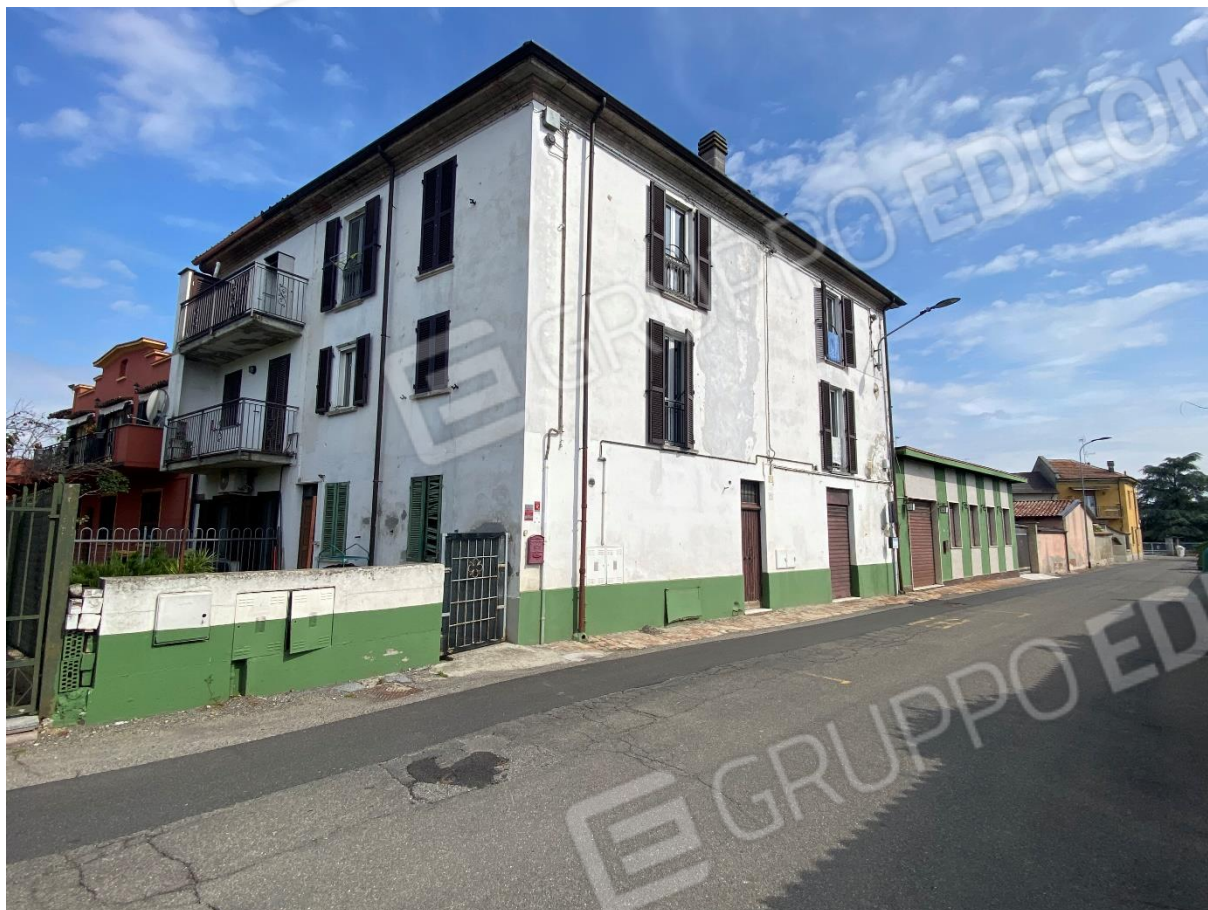
FOTO 5: prospetto fronte strada
