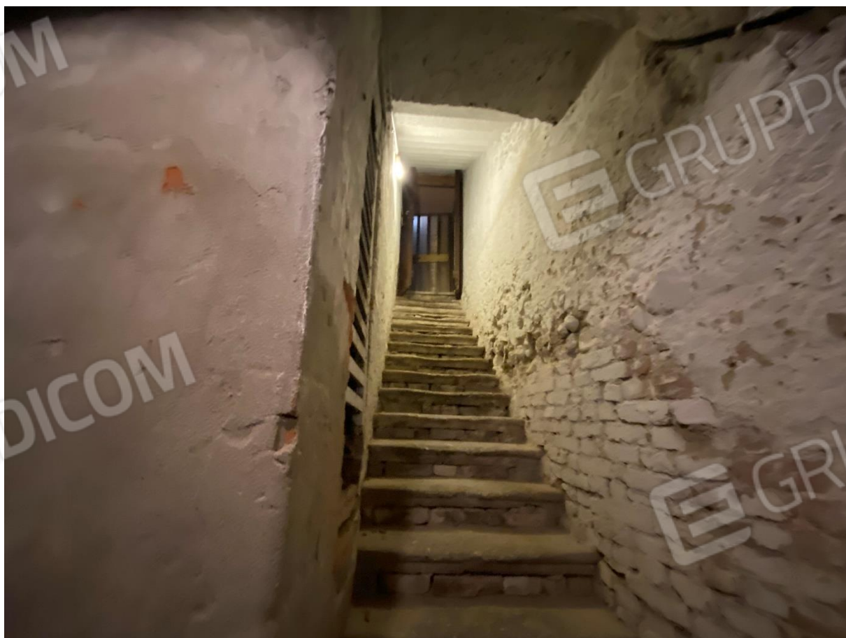
FOTO 18: scala di accesso al piano interrato
