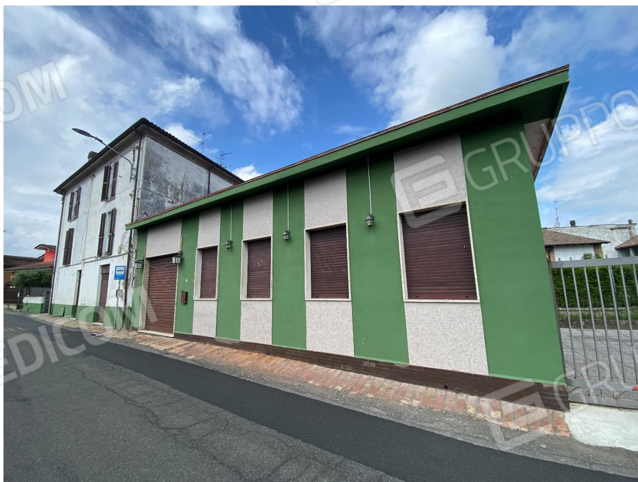
FOTO 4: prospetto fronte strada
