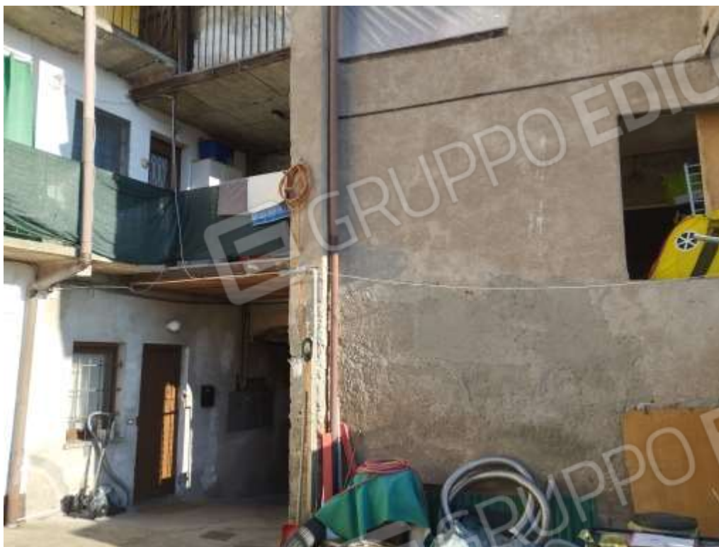
Foto 3) vista dell'immobile a Piano Primo
