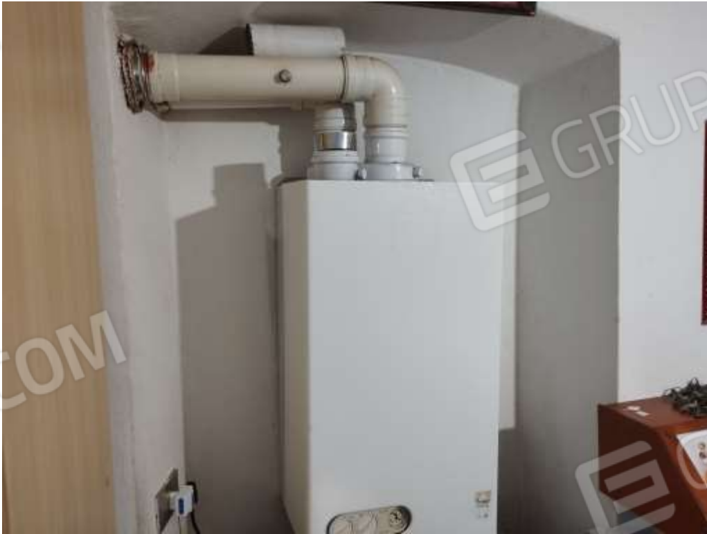
Foto 19) caldaia murale
