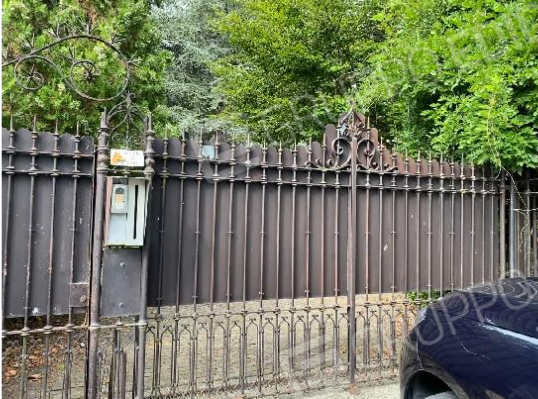
20. ingresso pedonale e carroia
