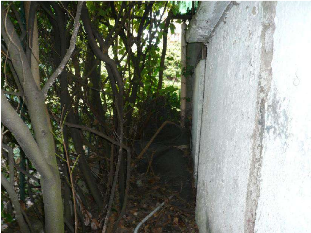
Foto 05 – Accesso al vano retrostante
