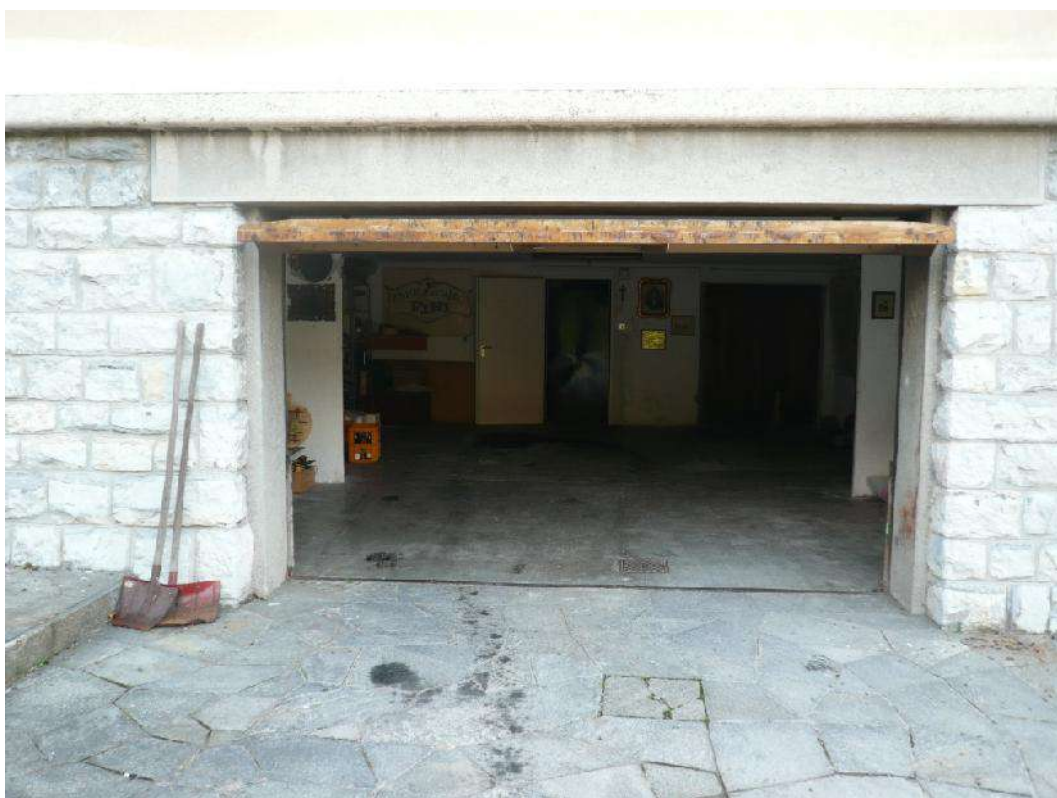
Foto 01 – Autorimessa con basculante
