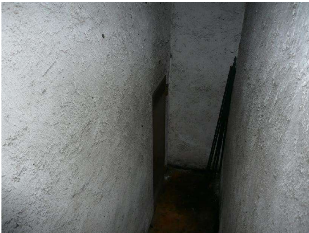
Foto 41 – Scale locale caldaia non comunicante con l'area abitabile
