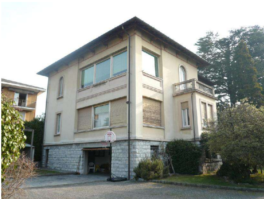
Foto 04 – Vista esterna dell'immobile
