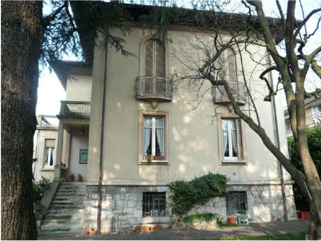
Foto 02 – Vista esterna dell'immobile
