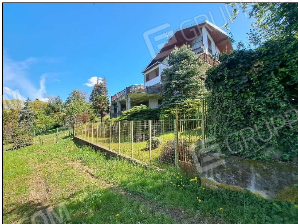
Recinzione divisoria con Lotto 1
