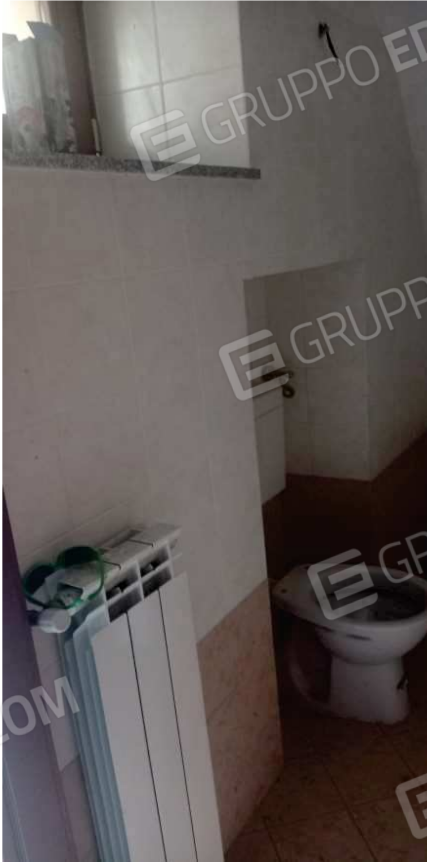
FOTO 32: particolare del bagno nuovo con il corpo riscaldante
