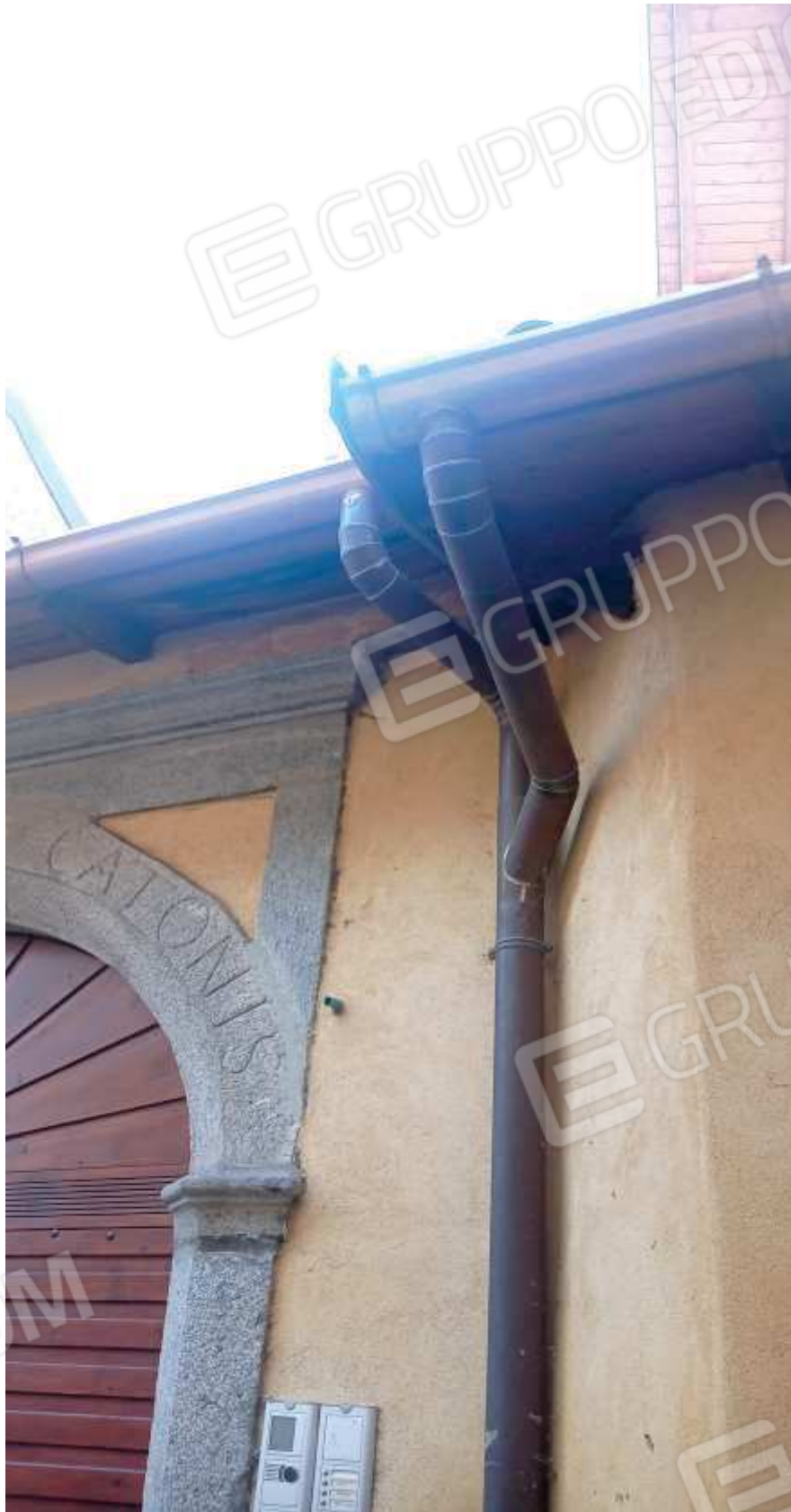
FOTO 19: vista delle lattonerie di scarico delle acque piovane in rame
