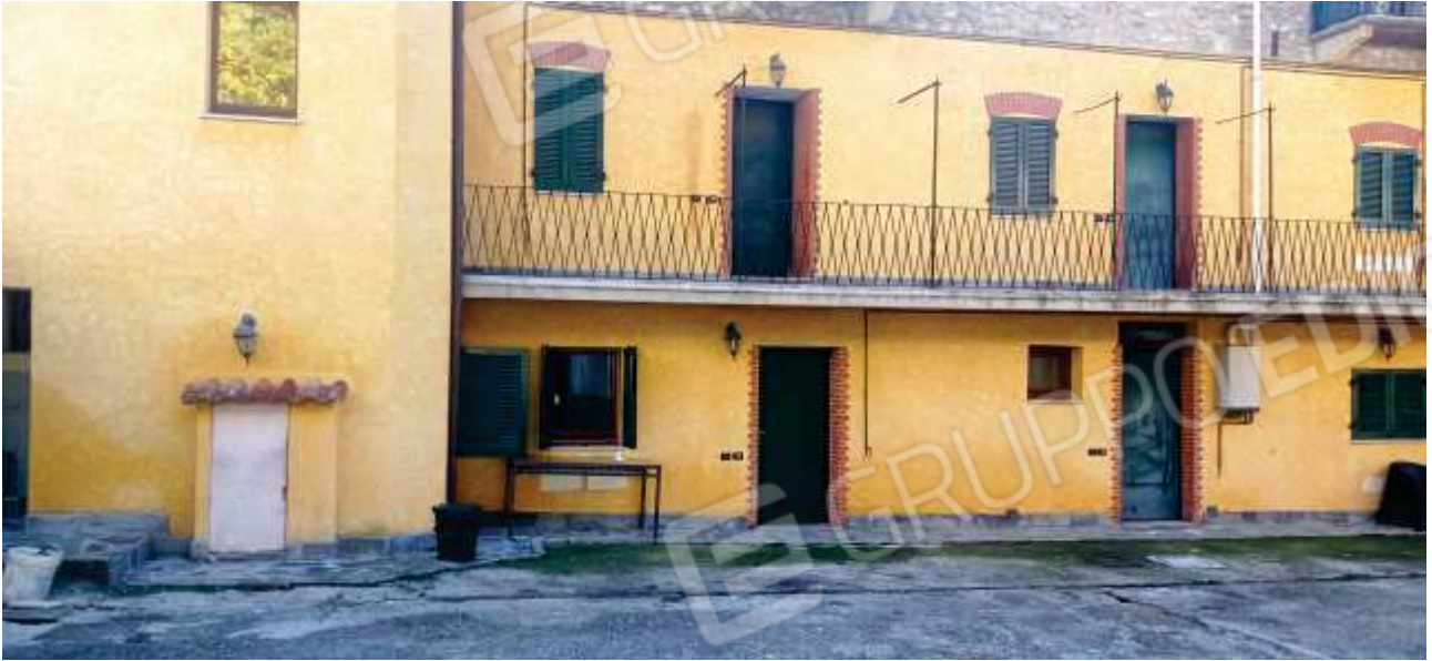
FOTO 7: prospetto del complesso edilizio sulla corte interna totalmente ristrutturata
