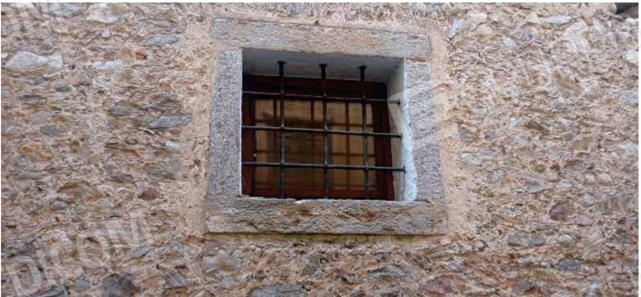
FOTO 6: finestra del complesso edilizio sulla via Garibaldi con serramenti nuovi e inferriata con nodo alla lombarda
