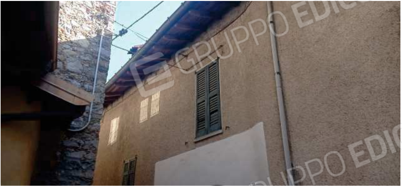
FOTO 5: prospettiva della via ove sito l'accesso alla corte dove localizzato l'accesso al bene l'accesso al bene
