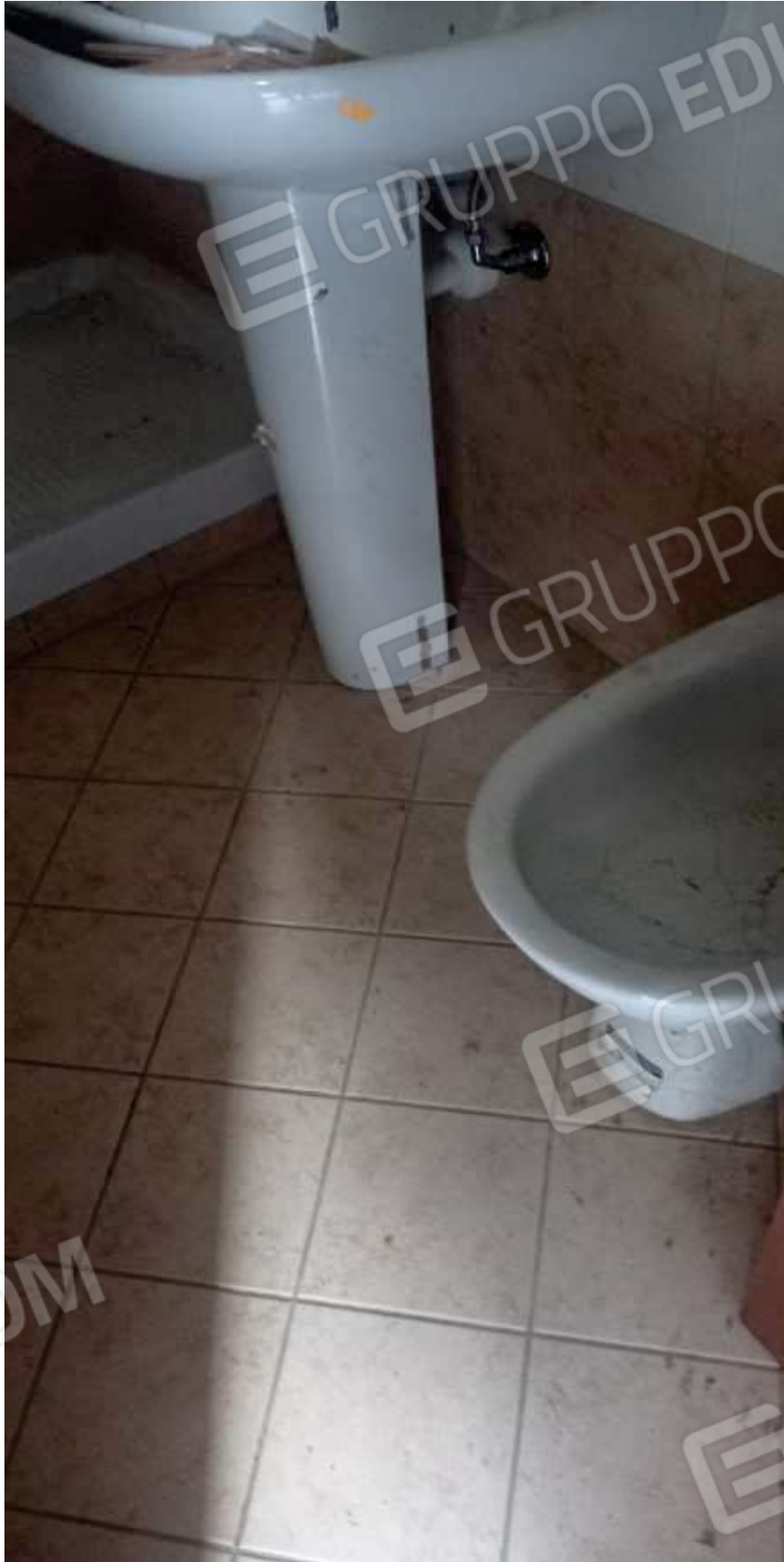
FOTO 30: particolare del bagno nuovo
