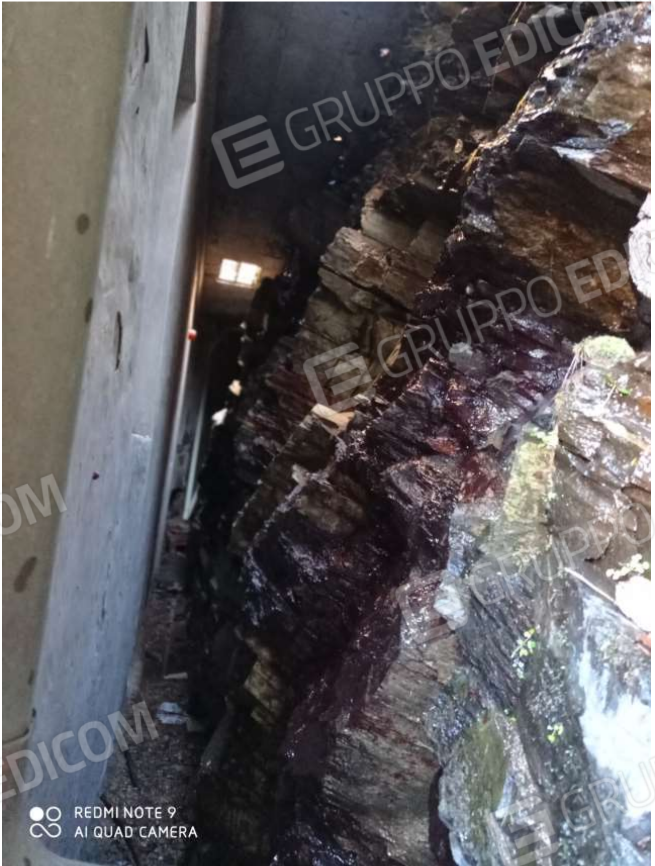
FOTO 9: il retro dell'autorimessa a ridosso della roccia
