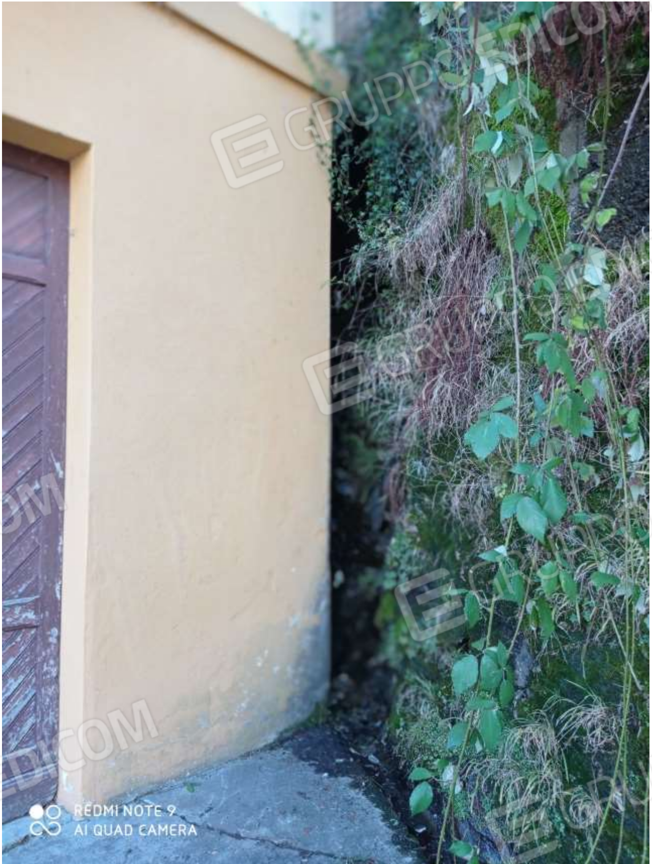
FOTO 8: il retro dell'autorimessa a ridosso della roccia
