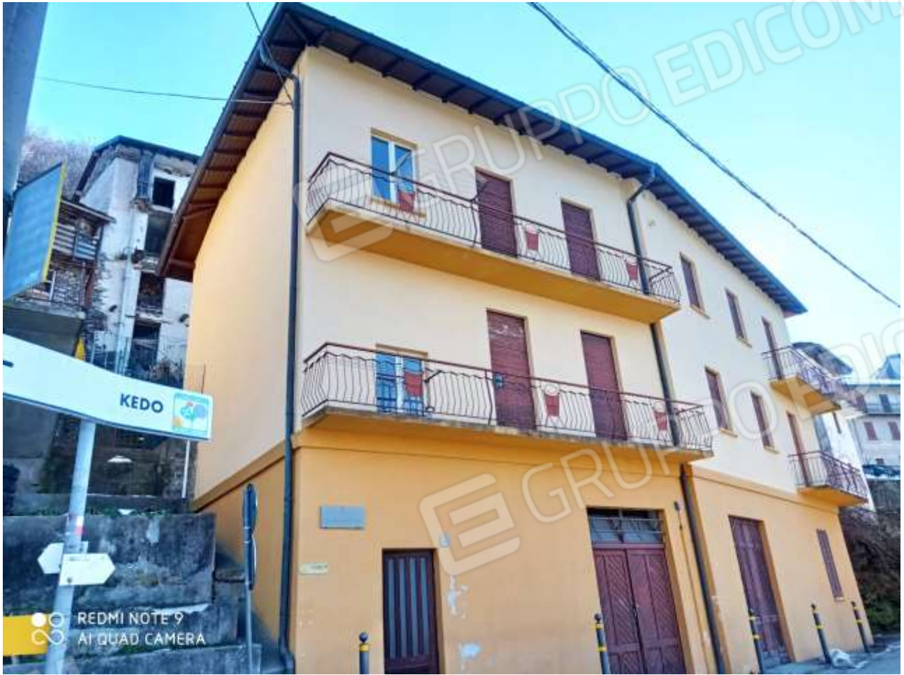
FOTO 2: la facciata sulla via Verdi
