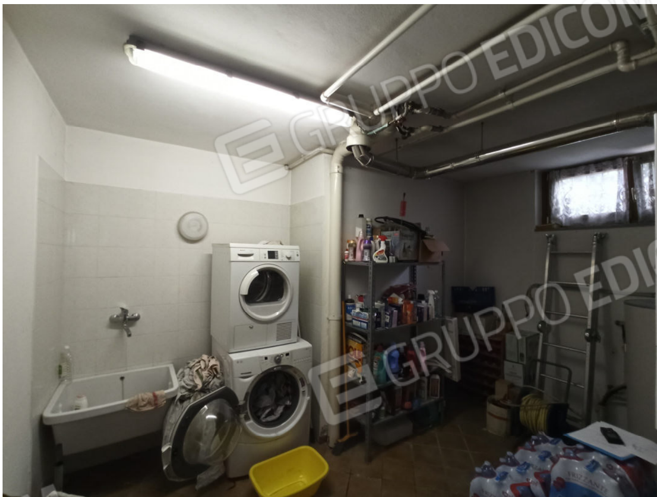
Vista locale tecnico-lavanderia a piano seminterrato
