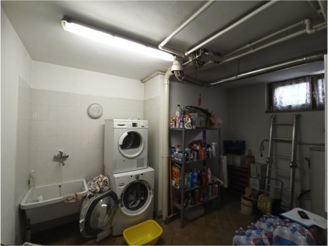
Vista locale tecnico-lavanderia a piano seminterrato
