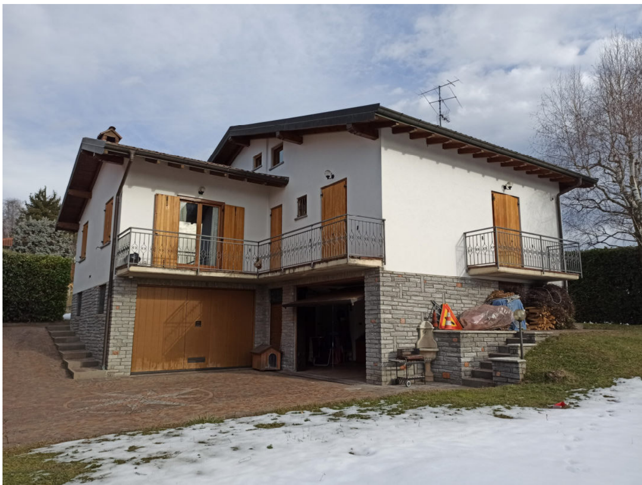
Vista da Sud-Ovest dell'unità immobiliare oggetto di perizia
