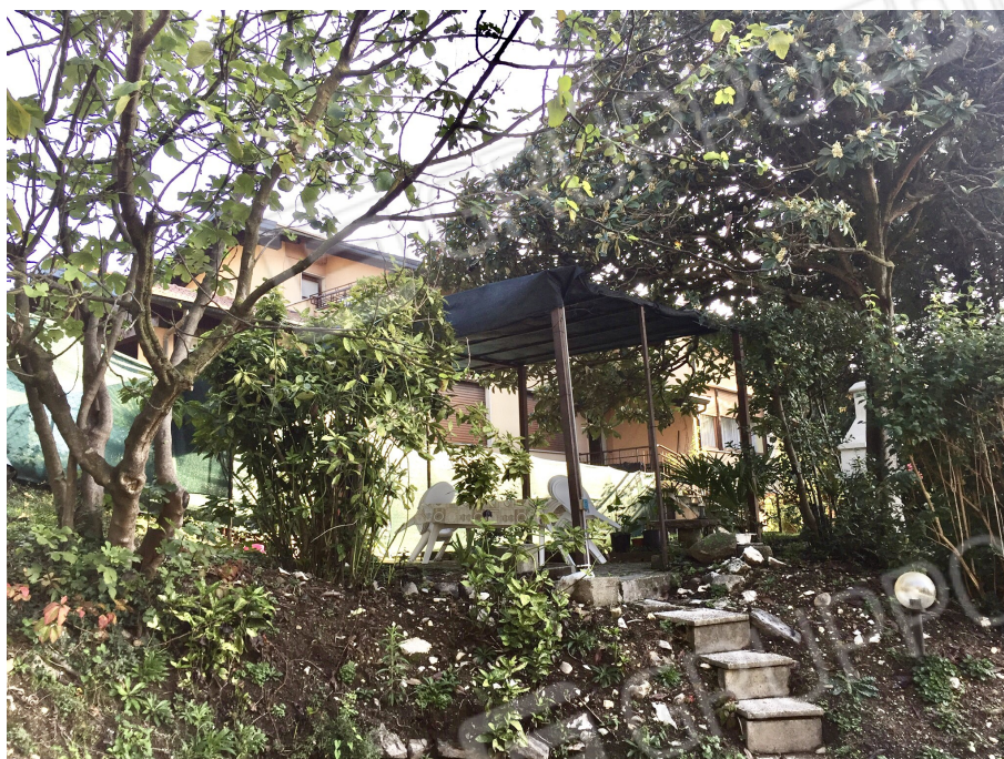
FOTO N. 3 PROSPETTO SUD CON ACCESSO DAL BOX AUTO
