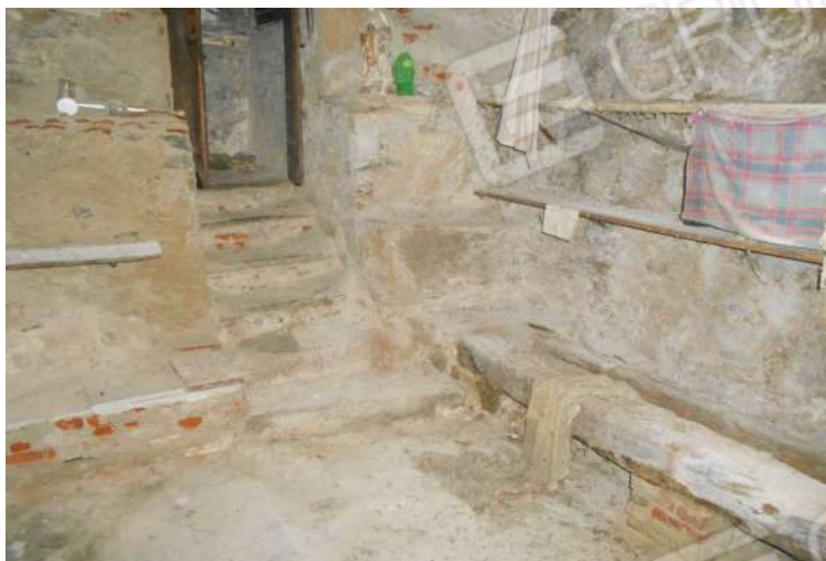
cantina ala sud est
