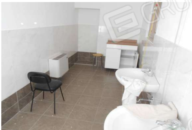
interni - secondo piano ristrutturato
