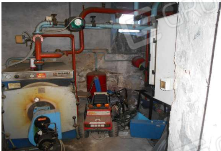
vecchio locale tecnico
