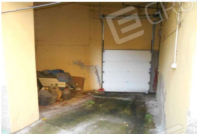
area ingresso carraio
