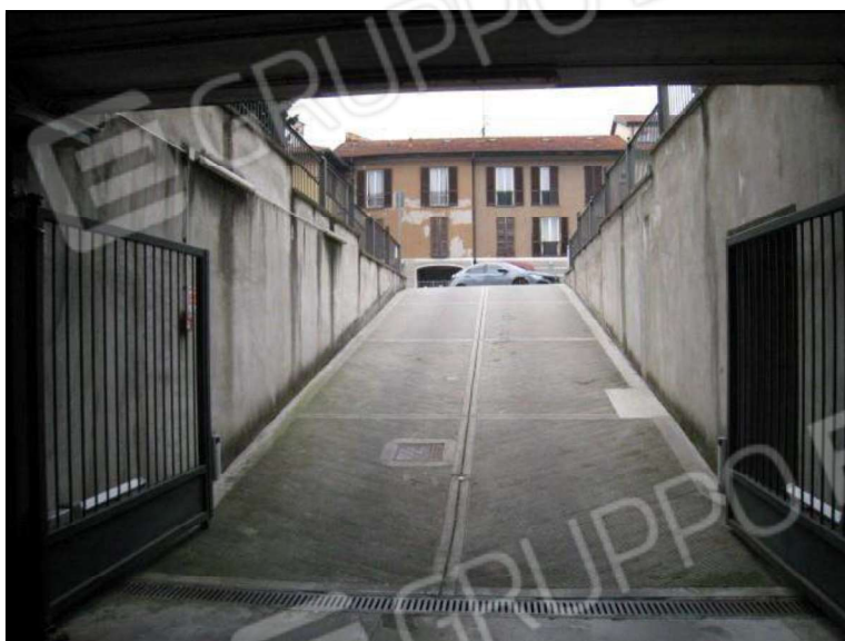
FOTO 11 PIANO INTERRATO. VISTA RAMPA CARRAIA DI ACCESSO ALLE AUTORIMESSE CHE SI DIPARTE DALLA PIAZZA REPUBBLICA.
