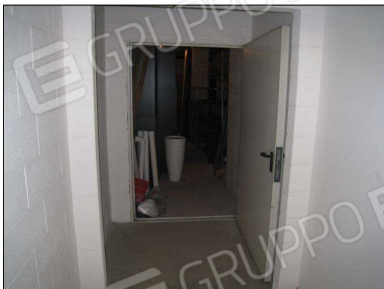
FOTO 14 PIANO INTERRATO. VISTA INGRESSO ALLA CANTINA MAPPALE 10406 SUB. 17.
