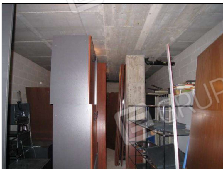
FOTO 15 PIANO INTERRATO. VISTA RIPRESA ALL'INTERNO DELLA CANTINA MAPPALE 10406 SUB. 17.
