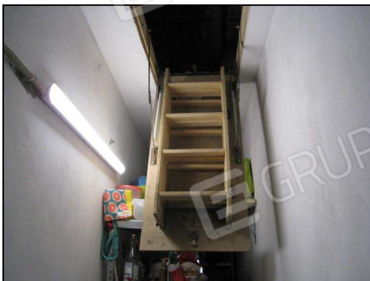
FOTO 24 U.I. MAPPALE 1424 SUB. 501 - PIANO PRIMO ALTRA VISTA RIPRESA NEL RIPOSTIGLIO VERSO SCALA RETRATTILE DI COLLEGAMENTO CON SOTTOTETTO NON AGIBILE.
