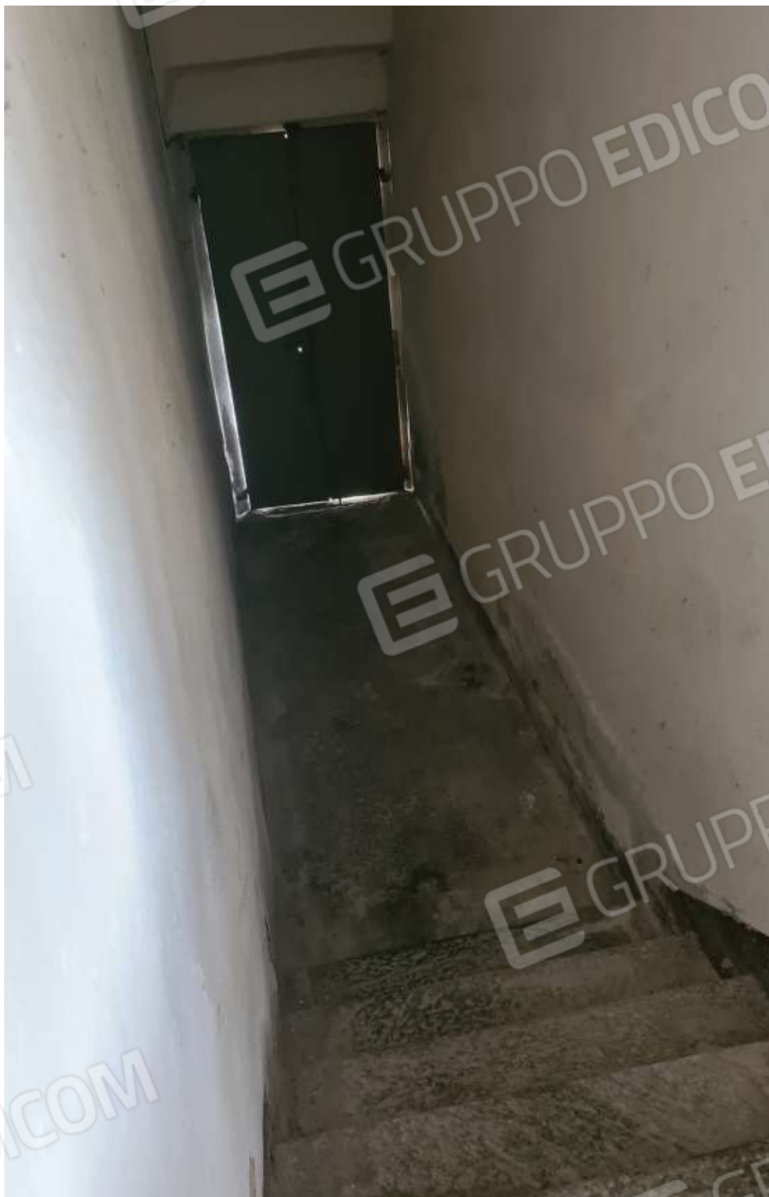
Mappale 537 sub. 507 – vista del corpo scala
