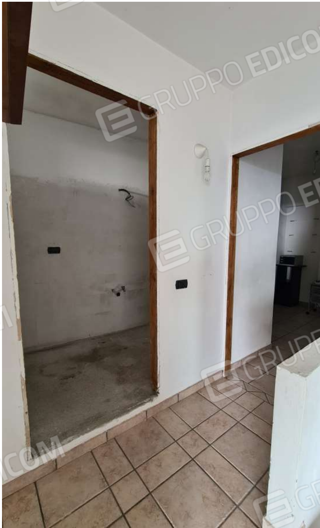
Piano Primo – disimpegno di accesso al w.c. ed allo studio
