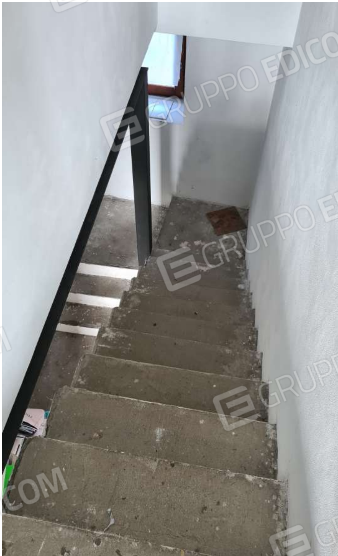
Particolare della scala interna
