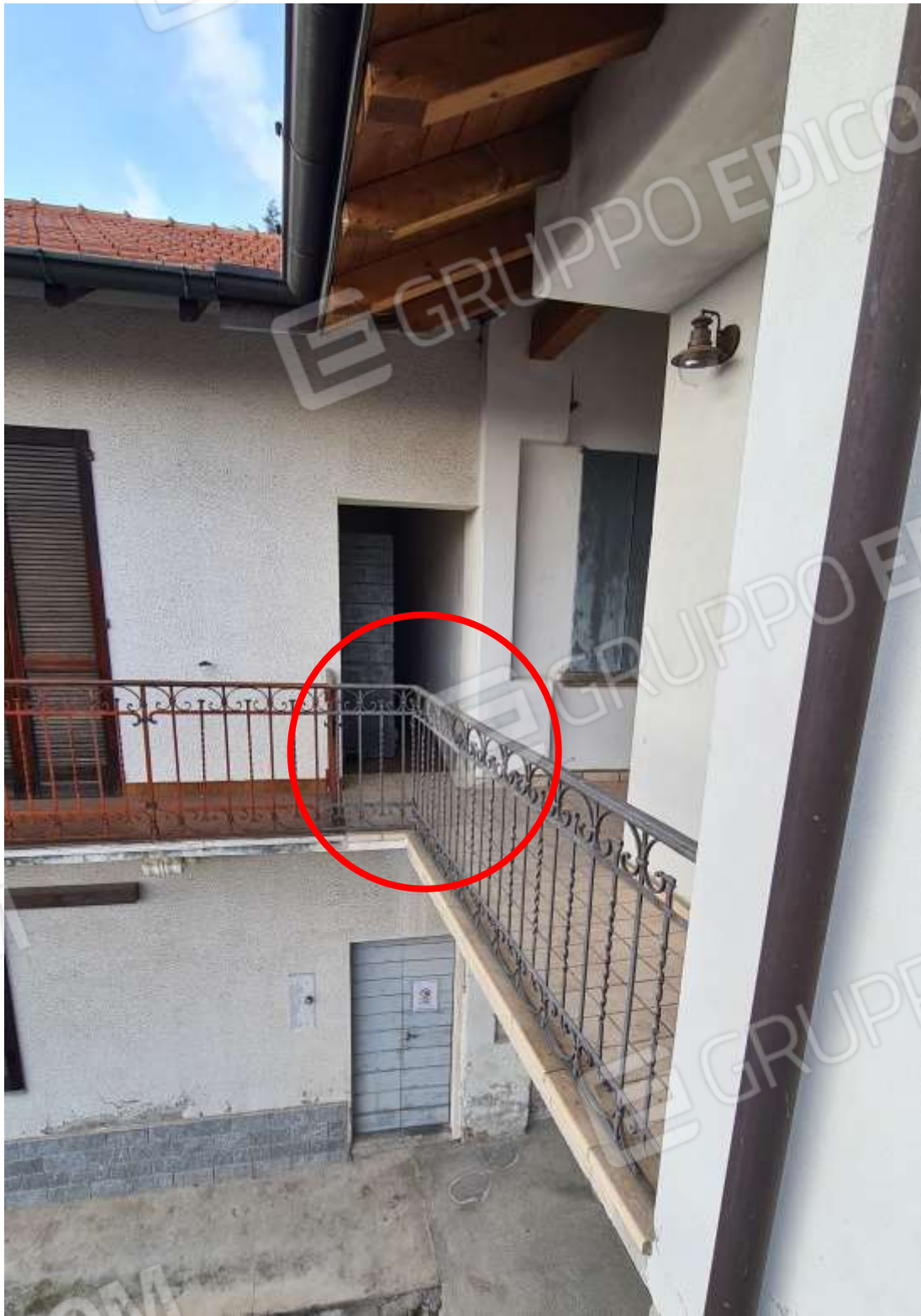
Mappale 537 sub. 506 – porzione di ballatoio a Piano Primo
