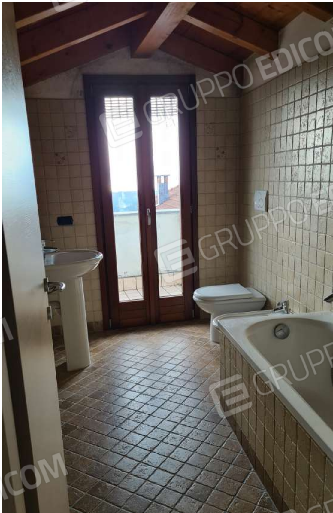
Piano Sottotetto – vista dello sgombero arbitrariamente trasformato in servizio igienico
