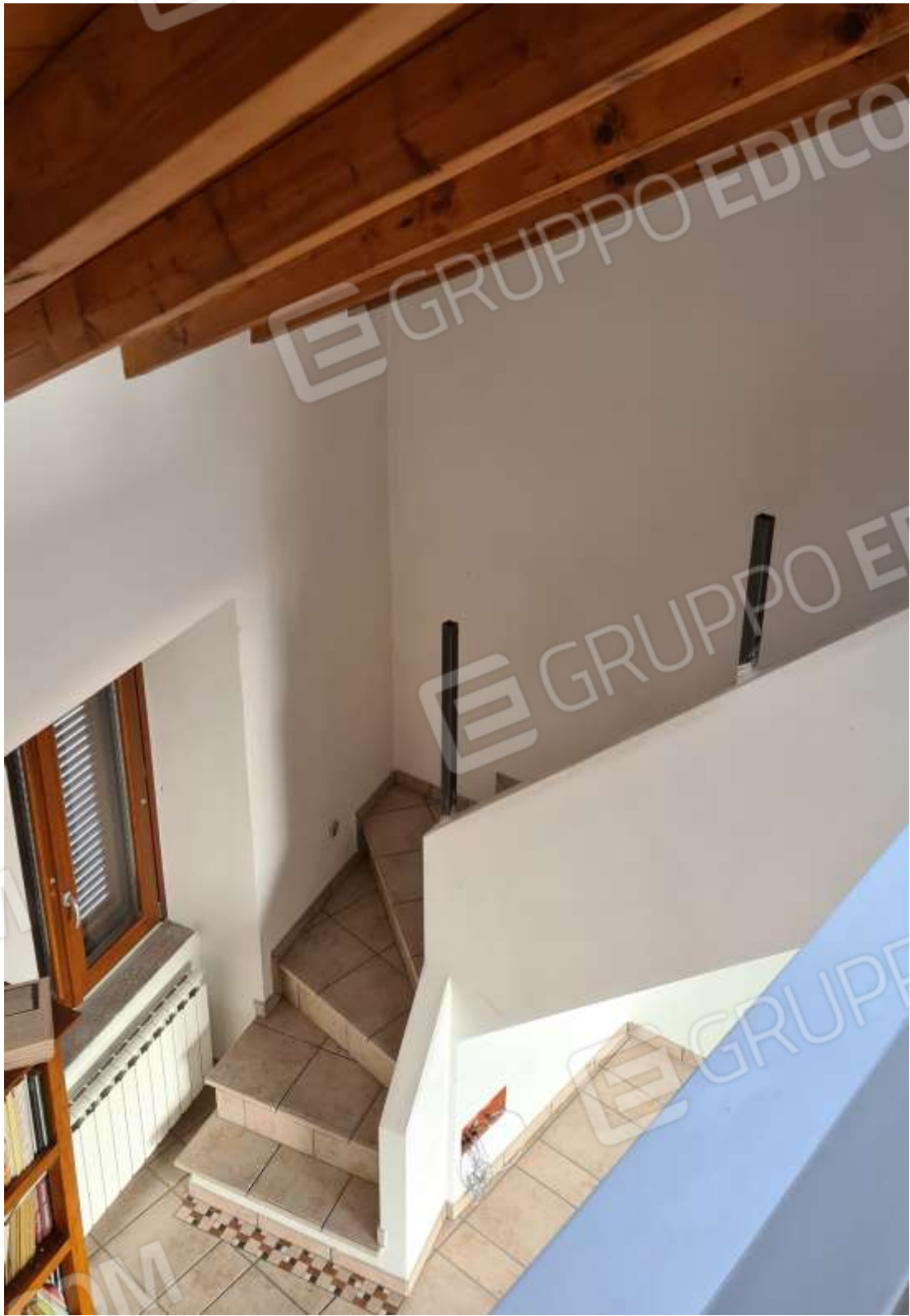
Vista della scala di accesso a Piano Sottotetto
