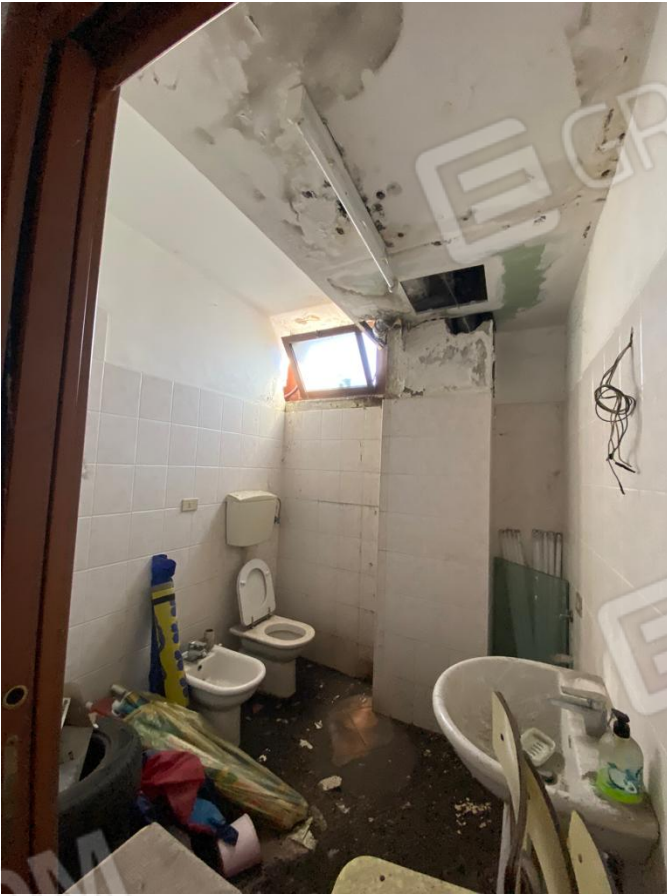
Interno bagno sud
