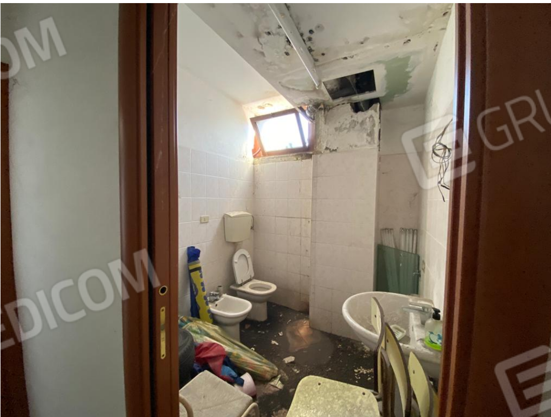
Interno bagno sud
