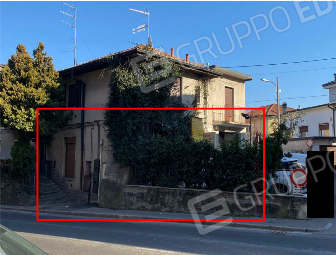
Vista da via Vanetti
