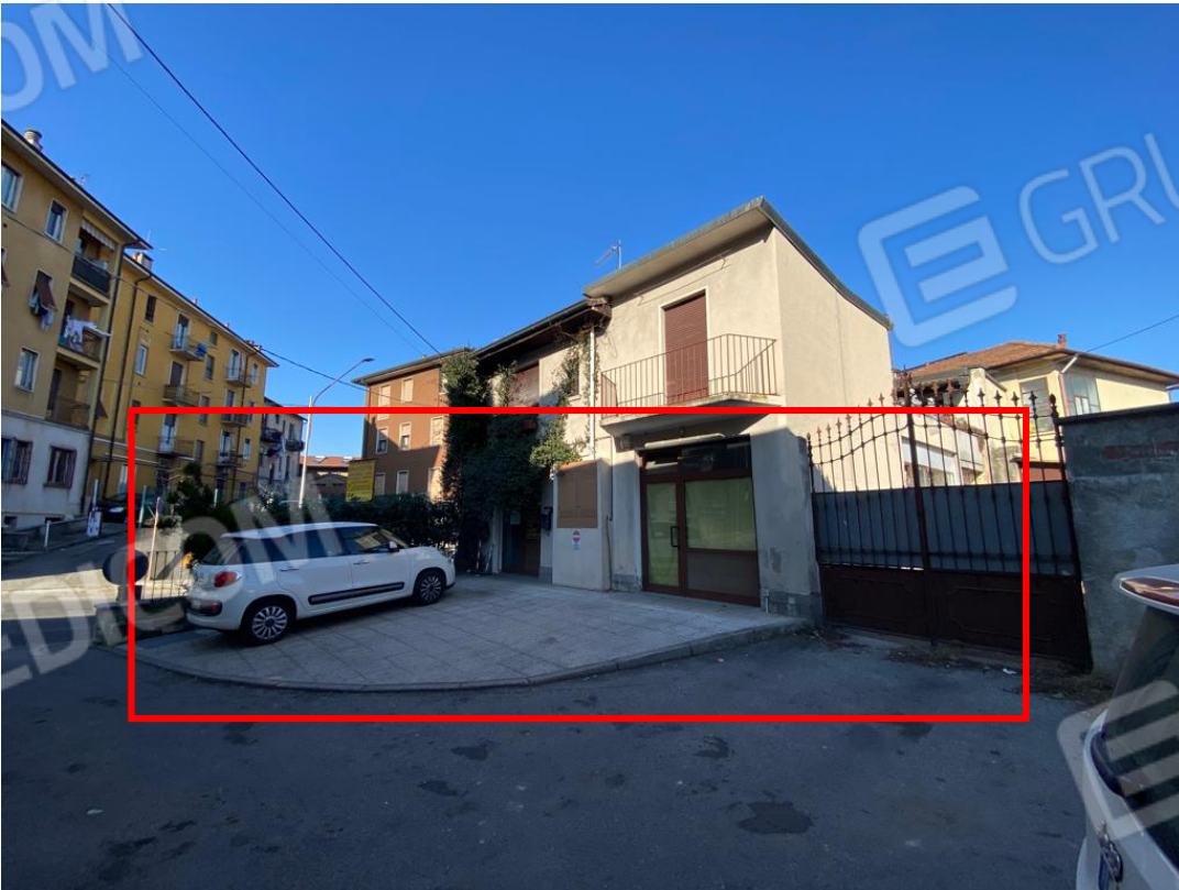
Vista da via Misurina (con cortile)
