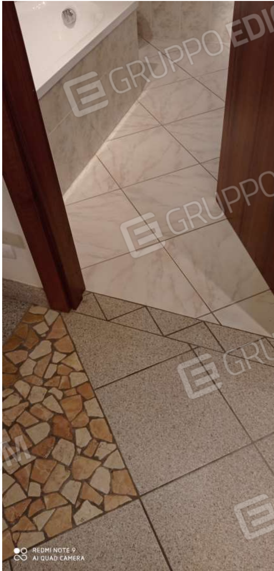
FOTO 17 – I pavimenti fra le camere e il bagno
