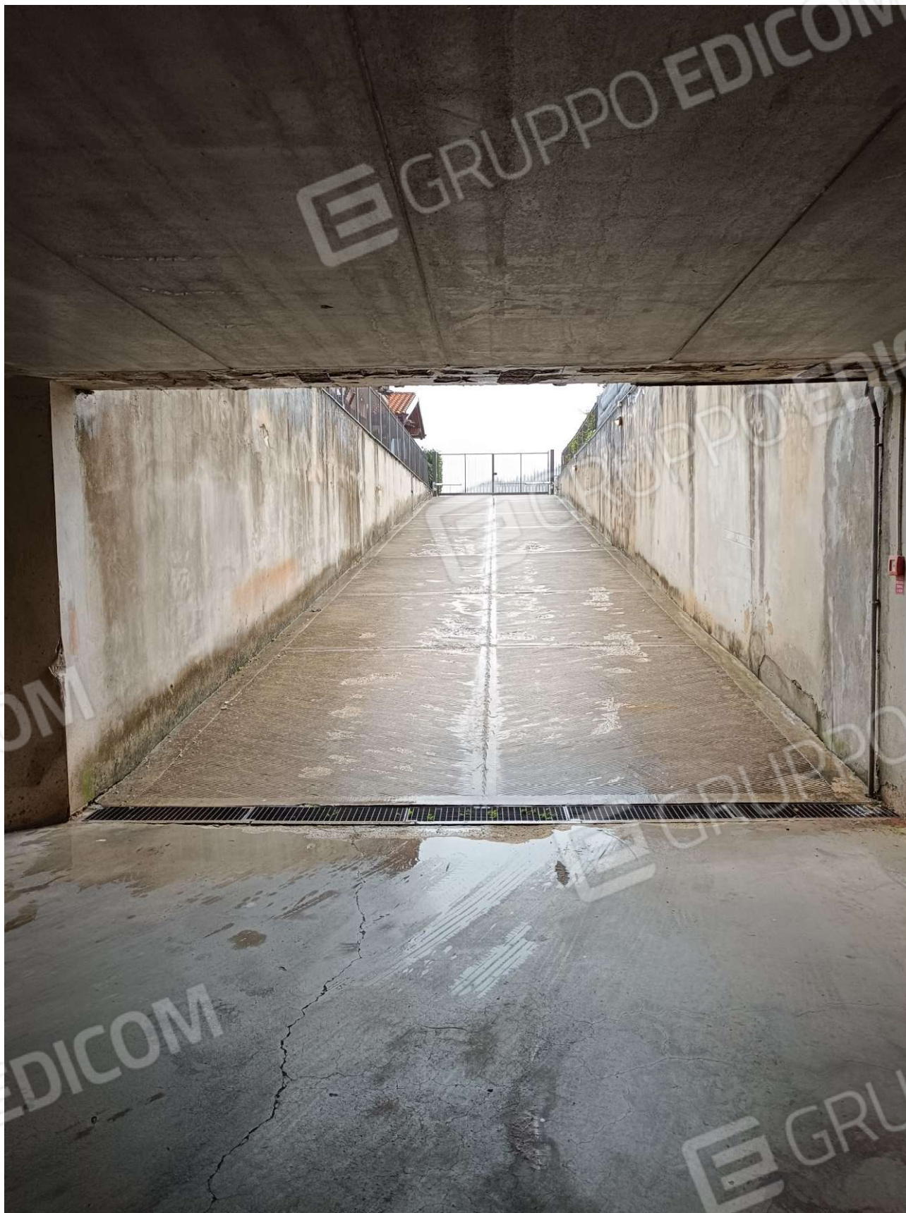
Rampa di accesso ai box
