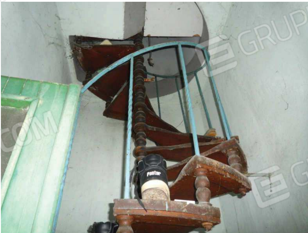
Locale 18 – Scala a chiocciola di collegamento con ripostiglio del piano soprastante
