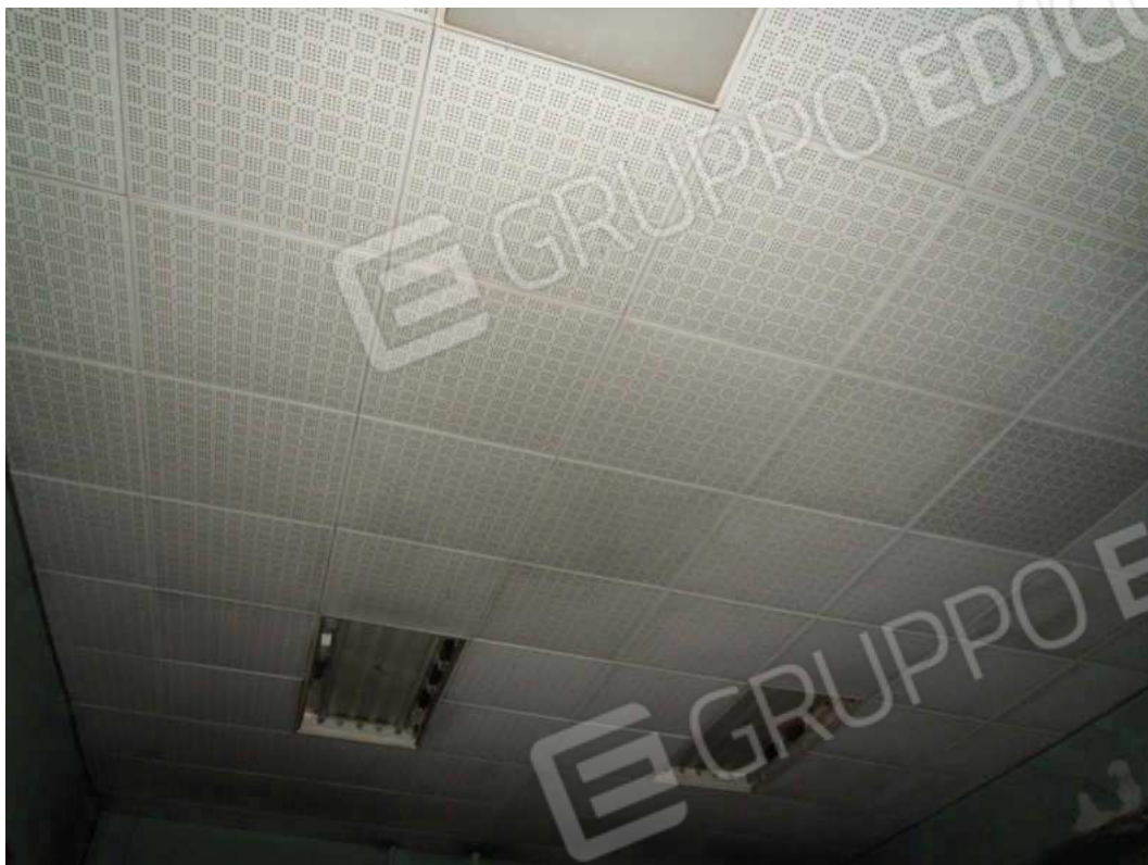
Locale 14 – Controsoffitto ispezionabile
