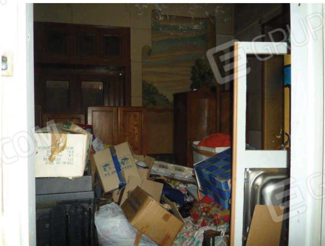
Locale 16 – Ripostiglio con pareti affrescate e porte vetrate in stile Liberty
