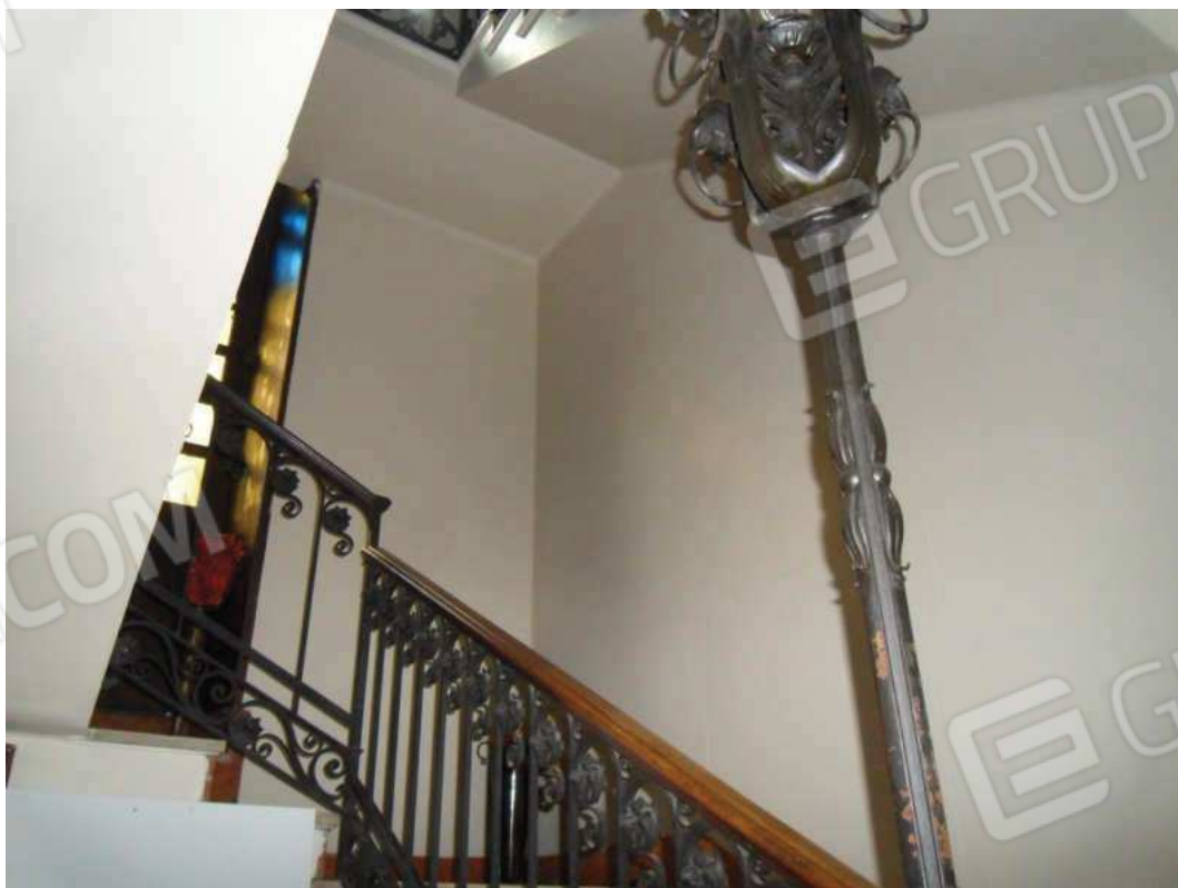
Locale 17 – Scala con parapetto in ferro decorato con motivi floreali in stile Liberty
