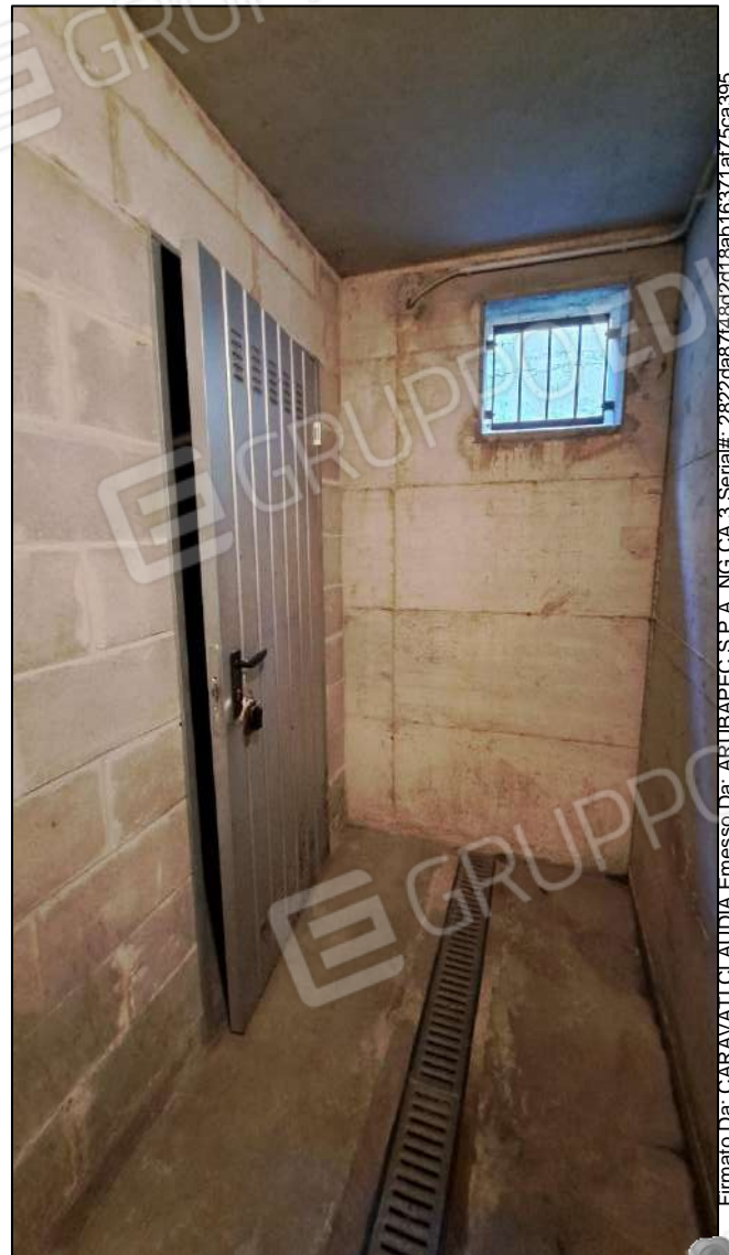
Accesso da corridoio comune
