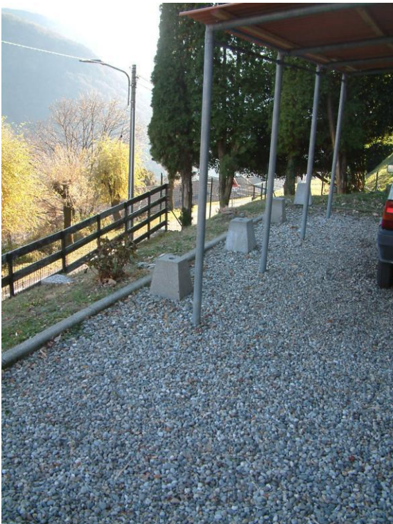
Foto 11 – STRUTTURA IN TUBI DI FERROE LASTRE IN FIBROCEMENTO DA RIMUOVERE
