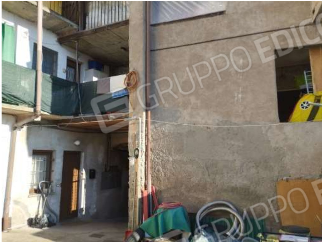
Foto 3) vista dell'immobile a Piano Primo
