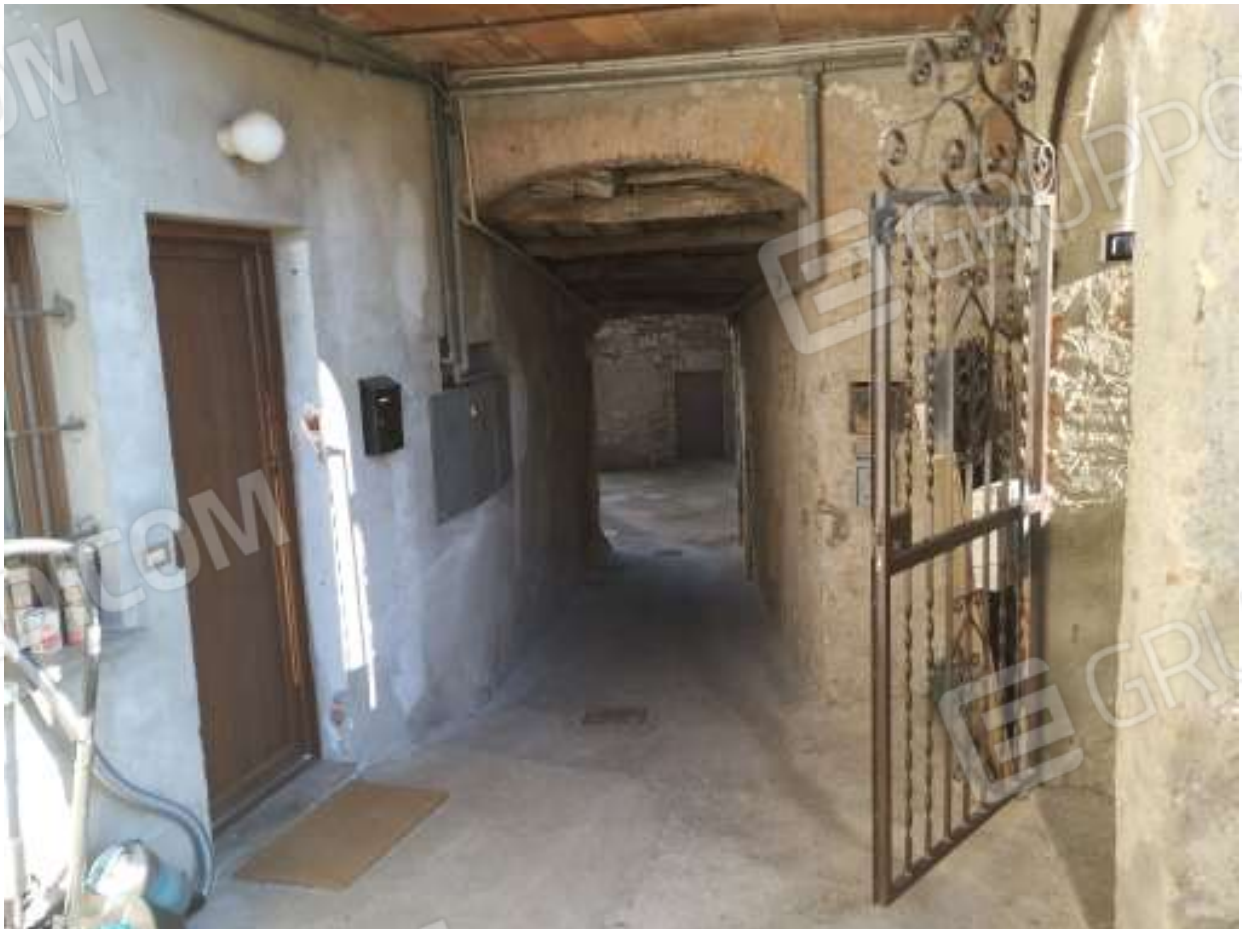
Foto 2) Passaggio coperto e cancello ingresso scala
