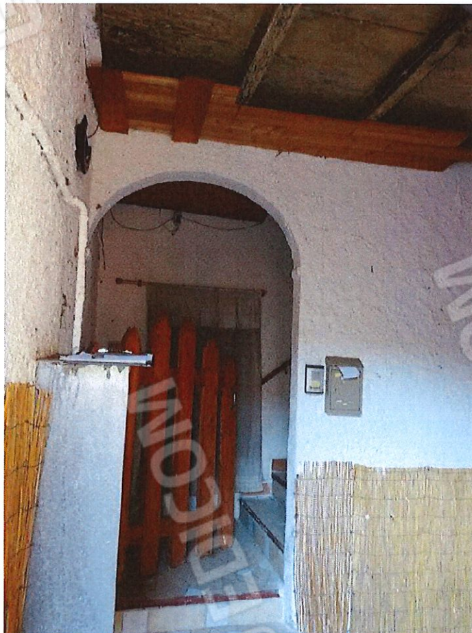
vista dell'ingresso e del vano scale
