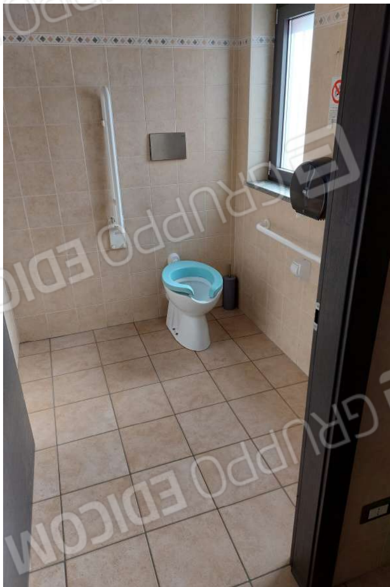
Foto n. 9: Bagno piano terreno
