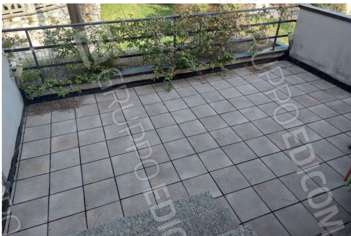
Foto n. 18: Terrazzo lato Nord - scoperto
