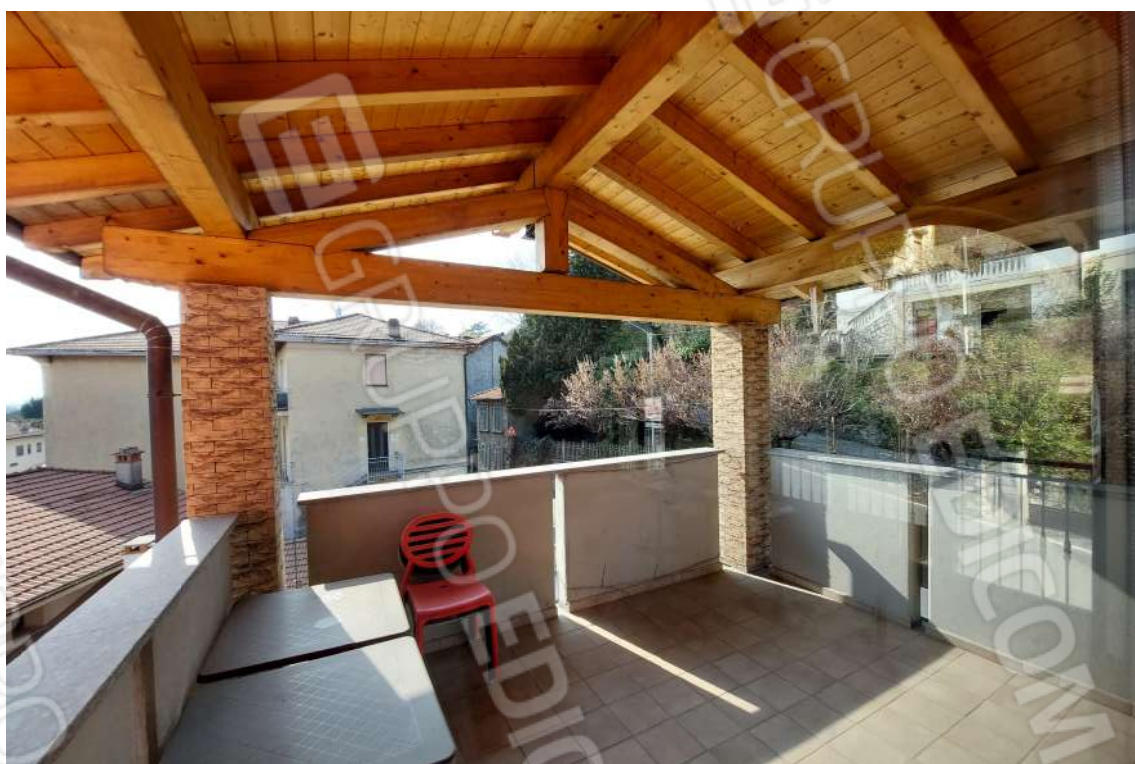
Foto n. 16: Porticato esterno lato Sud
