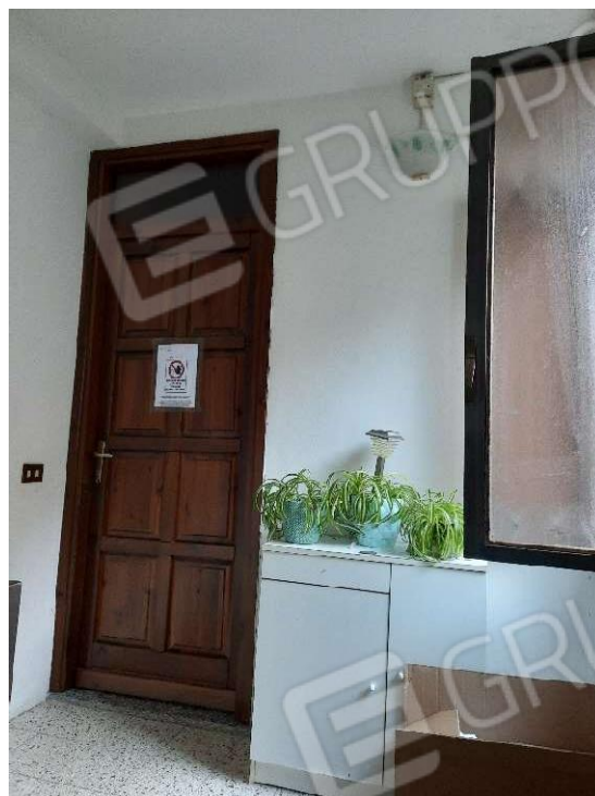
FOTO 4 – INGRESSO DA VANO SCALA
