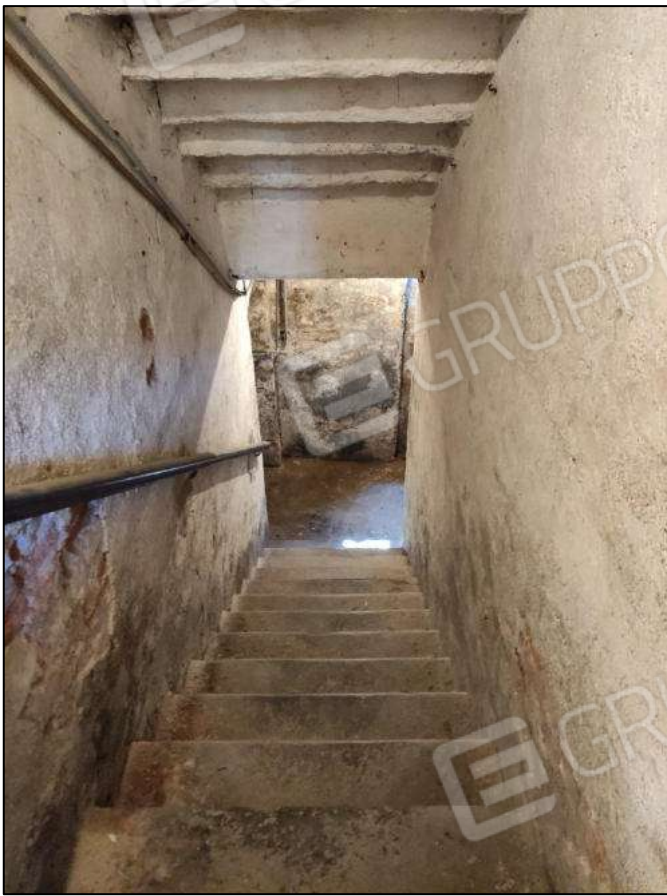
Scala di accesso alla cantina
