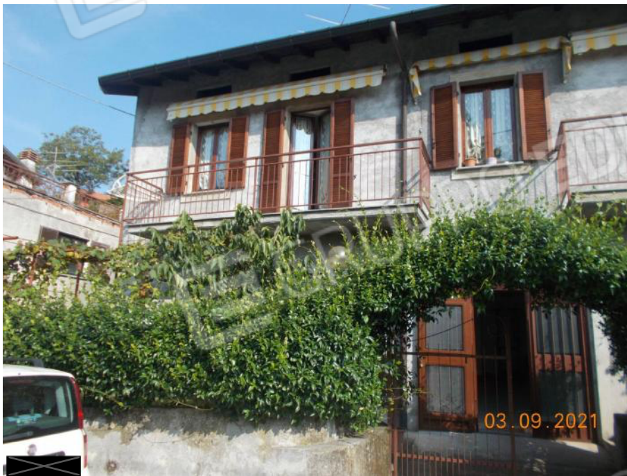
Foto 1 Ingresso abitazione e autorimessa
