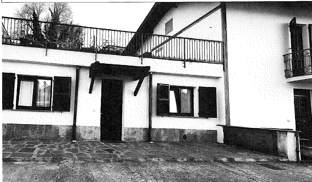
Figura 2 - 5143 sub 10 vista da ingresso carraio
