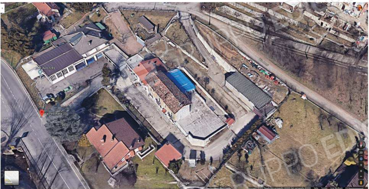
Figura 24 vista da sud ovest google
