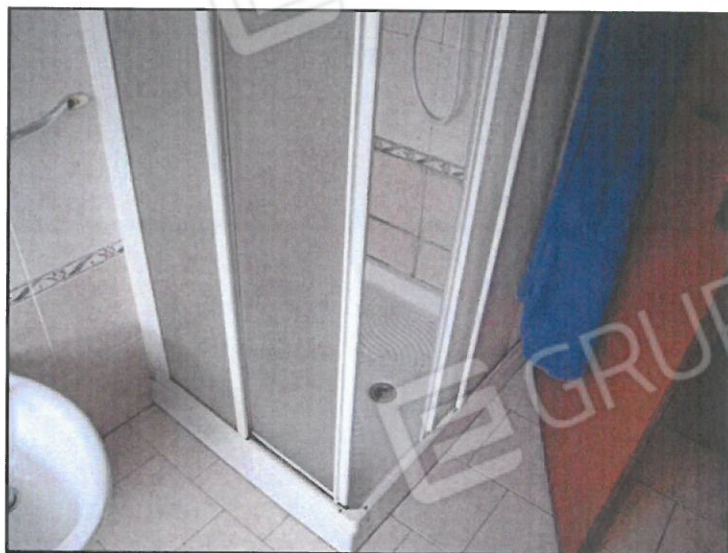
FOTO 36 U.I. MAPPALE 514 SUB. 3. ALTRA VISTA DEL BAGNO DELLA ZONA NOTTE.
