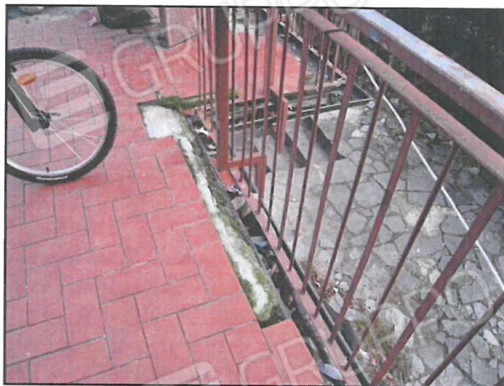
FOTO 20 U.I. MAPPALE 514 SUB. 3. VISTA PARTICOLARE DEL TERRAZZO DELLE FOTO PRECEDENTI.
